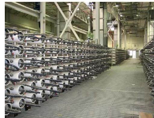
米国カリフォルニア州オレンジ郡地下水涵養システム(GWRシステム)における逆浸透膜処理施設(2007年供用開始)
