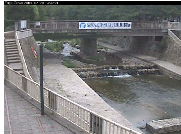
都賀川(甲橋付近)の急激な増水の様子 (神戸市河川モニタリングシステムより)
