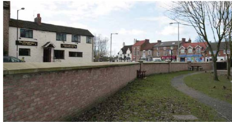
写真2 近年の洪水被害を受けて整備された洪水防御壁
