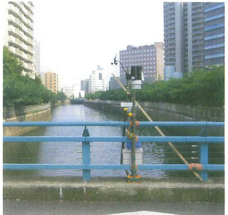
橋上に設置した装置
