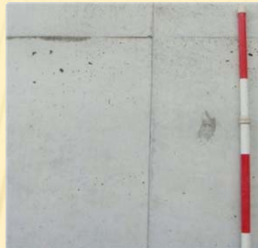
新しく健全なコンクリート擁壁。
