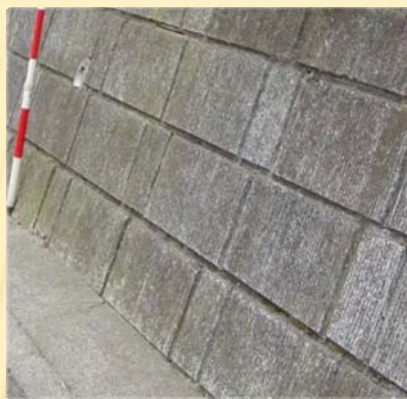
比較的新しく健全な大谷石積み擁壁。
