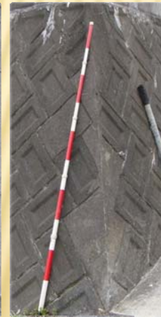
コーナー部の斜め方向にクラックがある。補修跡がある場合も、同様に評価する
