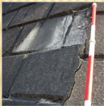
さらに合わせ目の破損や表面の剥離等も目立つようになる。
