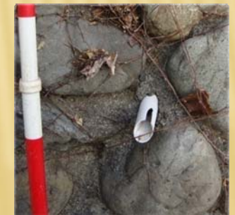
径の小さい水抜き穴
