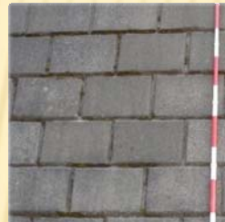
間知ブロック積み
