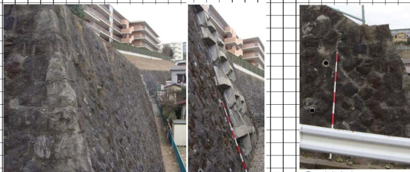
① 対象箇所を東側から望む。西側にはアンカー工が施工。 ② 東側側部のクラックの補修跡
