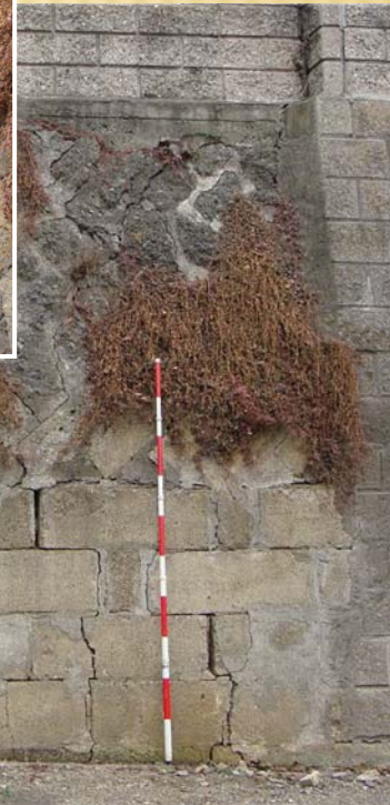
開口クラックや石積みのふくらみなどの変状が顕著で危険な状態にある擁壁
