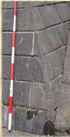
コーナー部の斜め方向にクラックがある。補修跡がある場合も、同様に評価する
