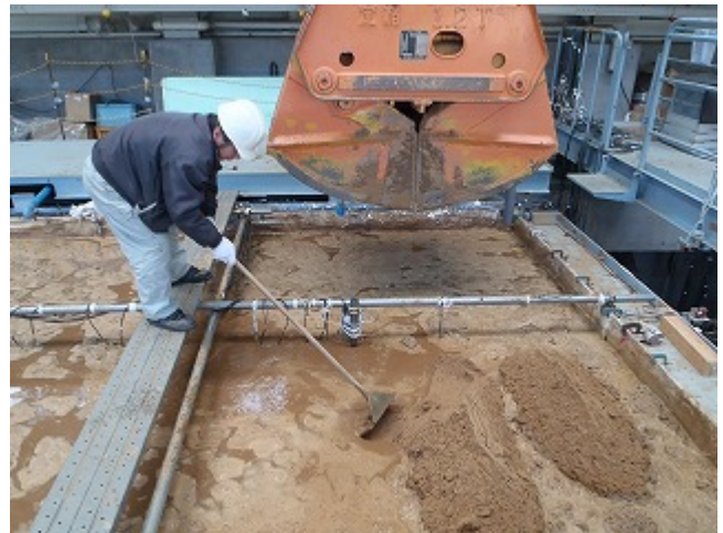
写真 3.7.6 砂敷き均し状況 2
