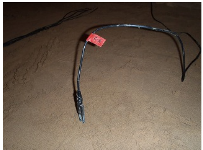
写真 2.3.12 TDR 土壌水分計設置状況
