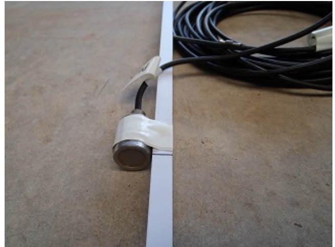
写真 2.3.8 間隙水圧計設置状況
