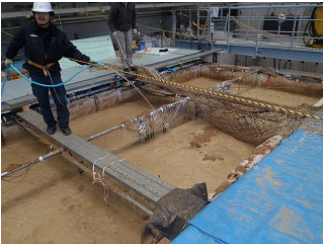
写真 3.7.5 砂敷き均し状況 1
