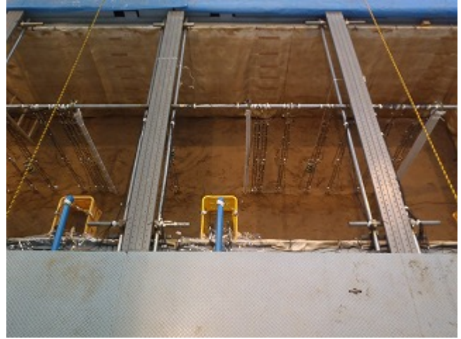
写真 3.7.2 位置出し状況
