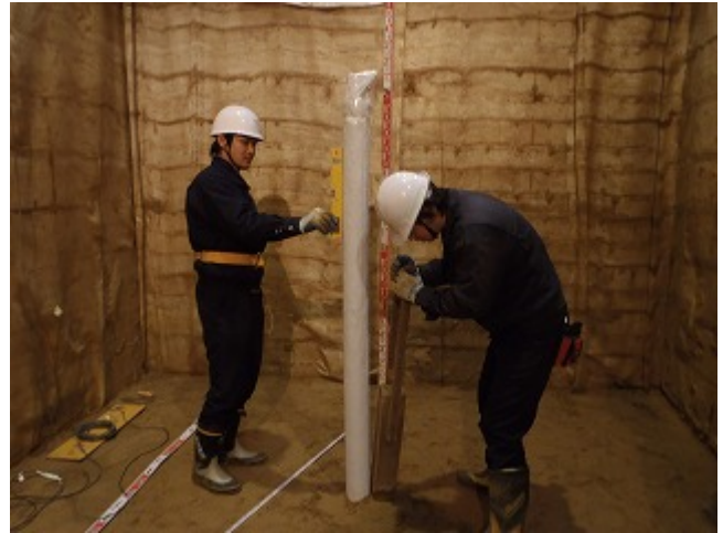
写真 5.1.2 埋め込み状況
