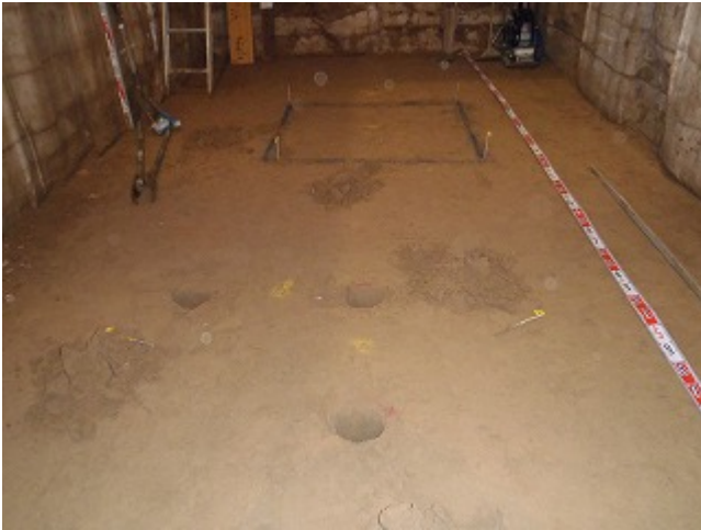
写真 5.1.1 位置出し根入れ掘削状況
