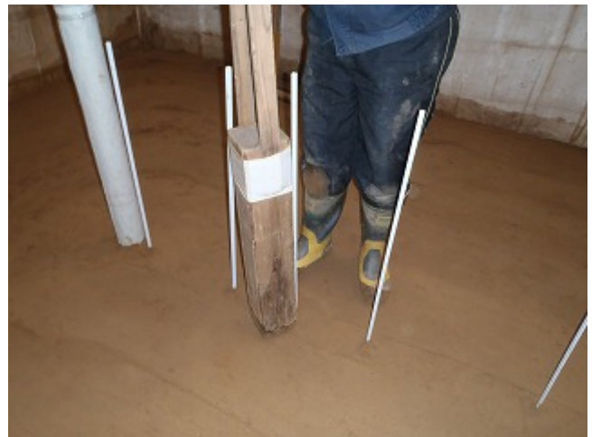
写真 3.8.4 細部転圧状況
