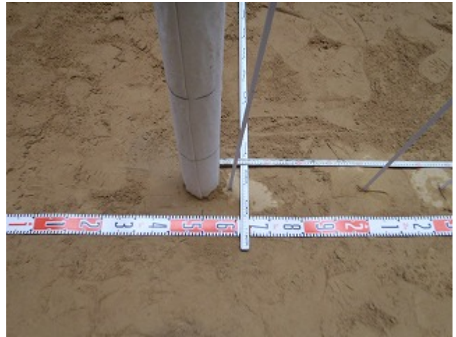
写真 5.1.4 埋め込み完了状況 2
