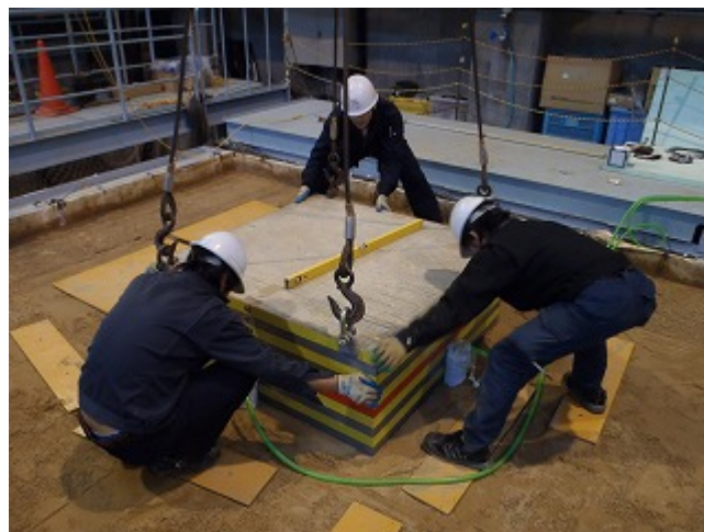
写真 5.2.2 住宅基礎設置状況
