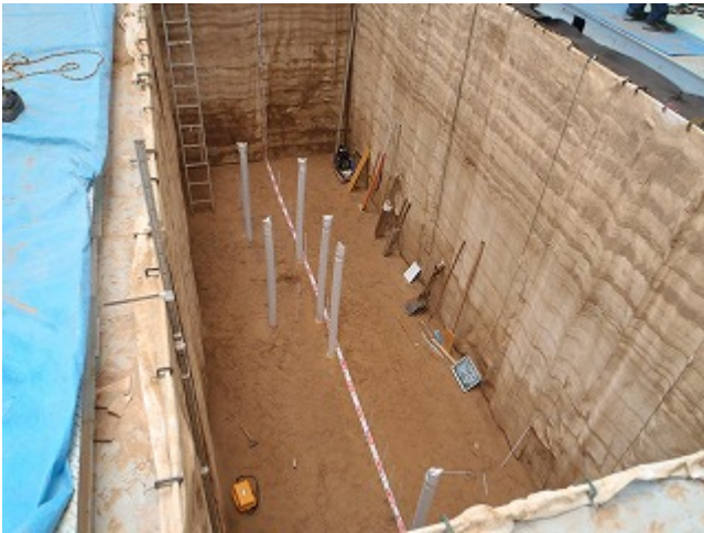
写真 5.1.3 埋め込み完了状況 1
