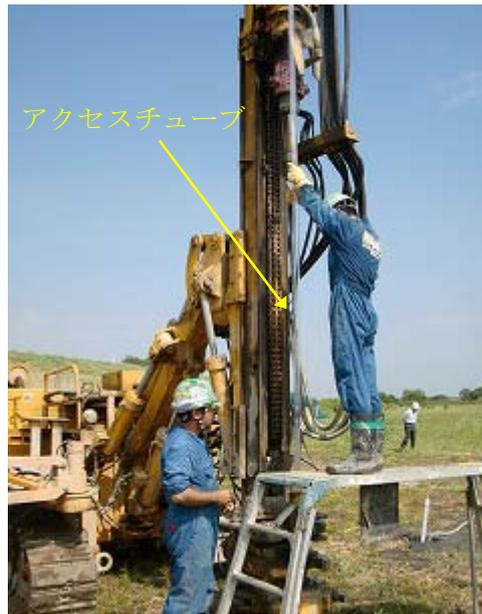
写真 2.1 アクセスチューブ建込状況
