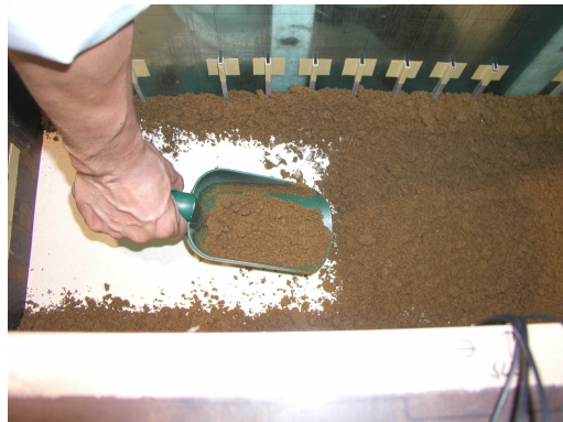
写真 2.2-2 地盤材料の撒き出し状況
