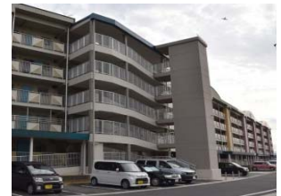
2棟をつなぐEV1基の増設 合理的なバリアフリー改修
