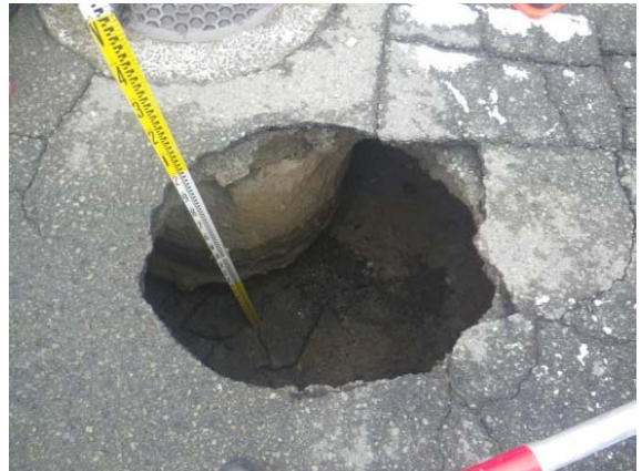
下水道起因道路陥没の事例
