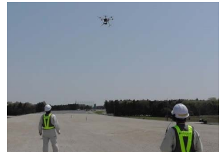
UAVIによる土工の計測 （施工・施工管理の効率化）
