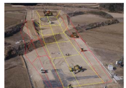
丁張り不要の施工現場 （施工・施工管理の効率化）
