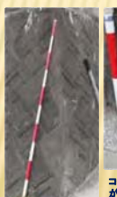
コーナー部の斜め方向にクラックがある。補修跡がある場合も、同様に評価する
