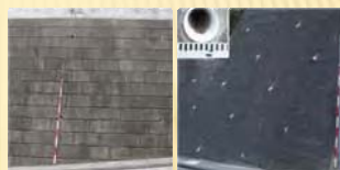
3m 2 に1ヶ所、内径75mm以上の水抜き穴が設置されている擁壁
