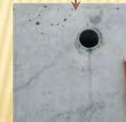
微細なヘアクラックが散見される程度は異常なし。
