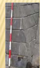
コーナー部の斜め方向にクラックがある。補修跡がある場合も、同様に評価する
