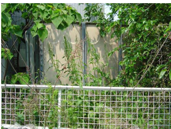
当初は高置水槽方式による給水方式であったが、受水層と高置水槽の管理が放棄されている（現在は直結給水方式になっている）。
