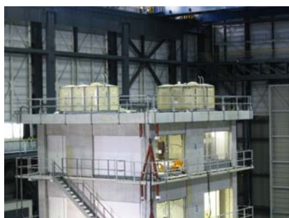
図13 高架水槽（新・旧）
