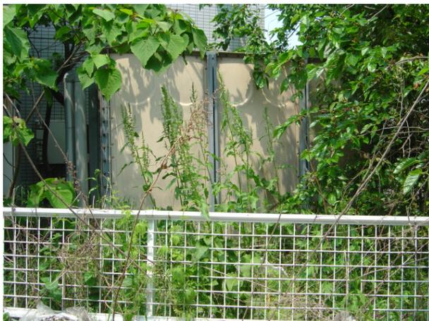
当初は高置水槽方式による給水方式であったが、受水層と高置水槽の管理を放棄し、現在は直結給水方式に。3階までしか上水を利用できない
