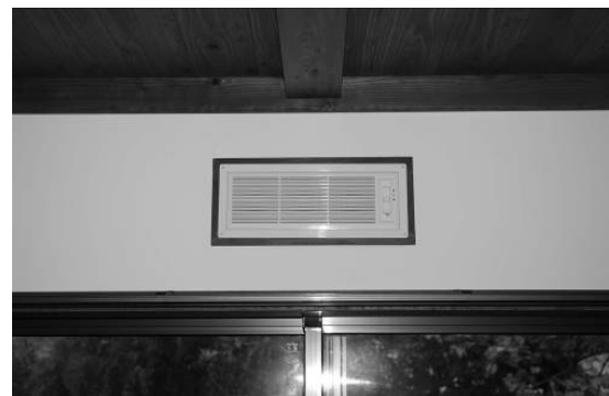
図 16.2.25 自動感知式換気口
