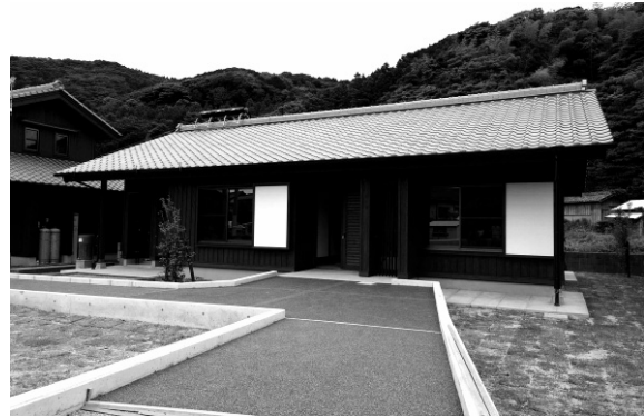
図 16.2.37 完成したB棟
