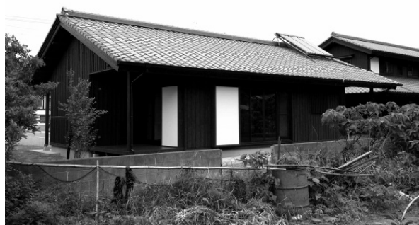
図 16.2.46 外壁は杉板張り。屋根の上に太陽熱温水器がのる
