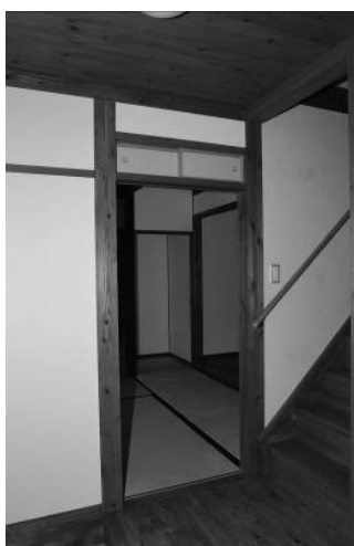
図 16.2.27 各扉上部のガラリ戸
