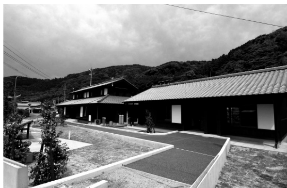
図 16.2.47 完成したA棟とB棟
