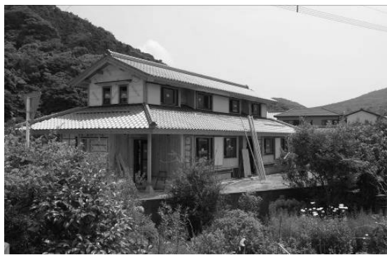
図 16.2.16 外壁仕上げが進む現場
