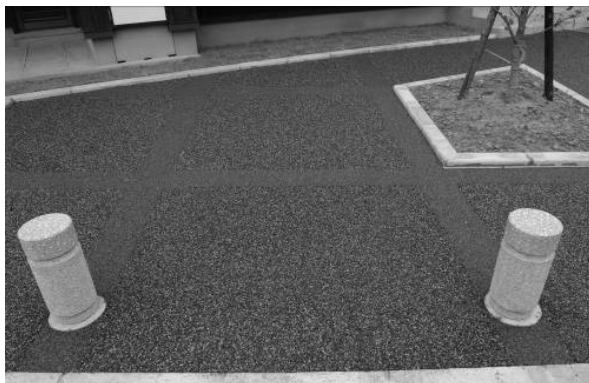
図 16.2.32 上五島産の採石を活用した本格的な透水性舗装
