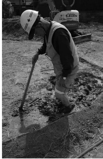
図 16.2.9 取り壊された公営住宅の土壁材料の再利用
