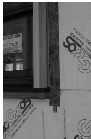
図 16.2.13 窓枠と断熱材の取り合い
