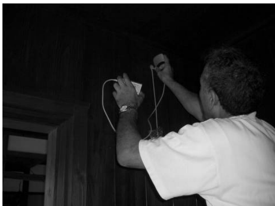
図 16.3.1 温湿度センサーの取り付け
