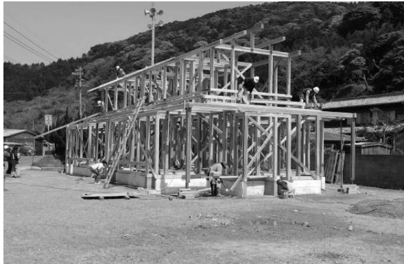
図 16.2.31 在来軸組工法による架構
