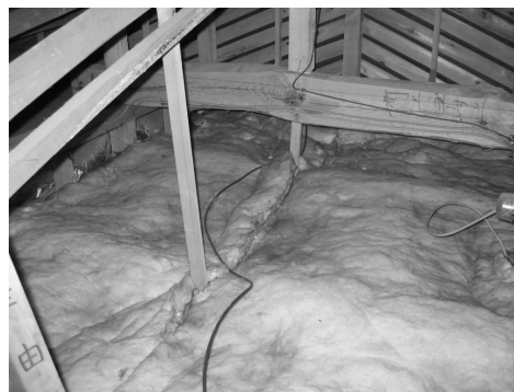
図 15.5.9 小屋裏の断熱材の状況
