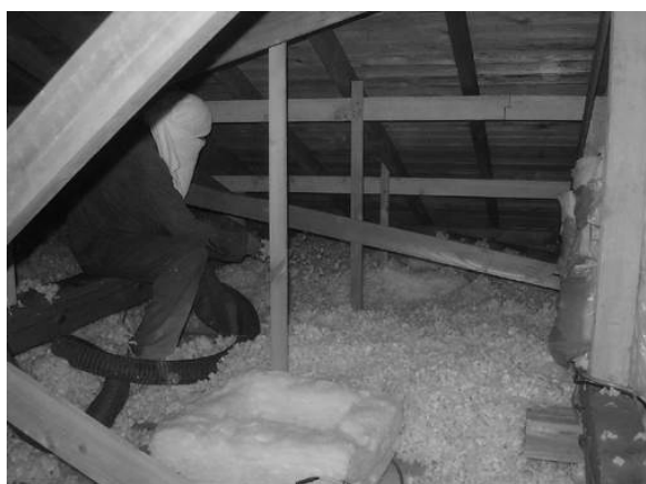
図 15.1.12 BGWの吹き込みの様子
