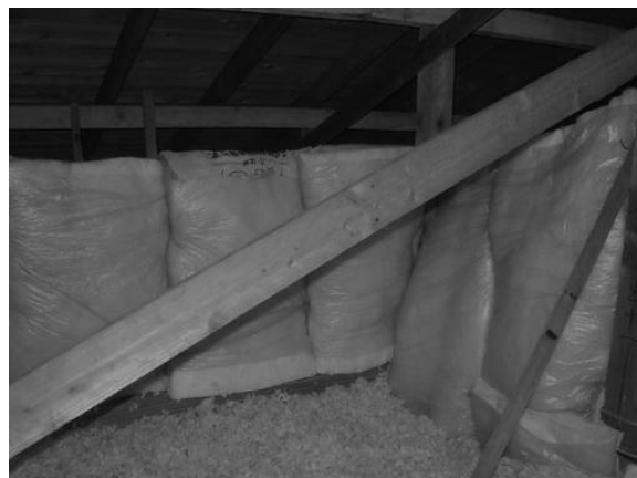
図 15.1.13 勾配天井の壁部分に断熱材を設置
