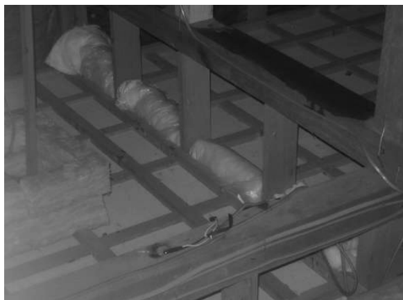
図 15.1.11 間仕切壁の上部に通気止めを設置
