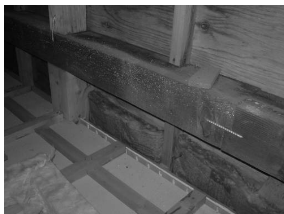
図 15.1.9 小屋裏から確認できる外壁断熱材
