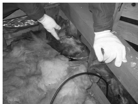
図 15.5.12 小屋裏へ出ている外壁断熱材
