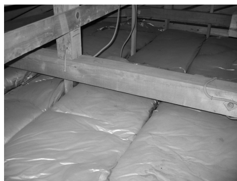
図 15.5.10 納戸上部は外壁用の断熱材が使用されている。
