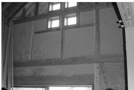
写真 14.4.4 試行検証した住宅の土壁
