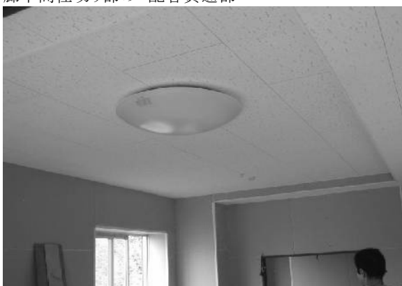
平成14年10月 9日 照明器具取付(居間)
