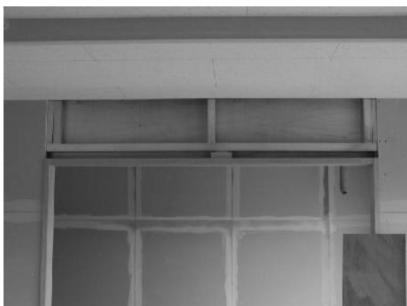
平成14年10月 9日 和室-居間間の欄間(パネル撤去状況)
