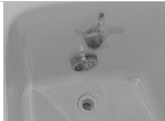
平成14年10月17日 ユニットバス注湯口
