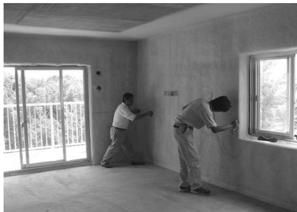
平成14年8月29日 建築墨出し
