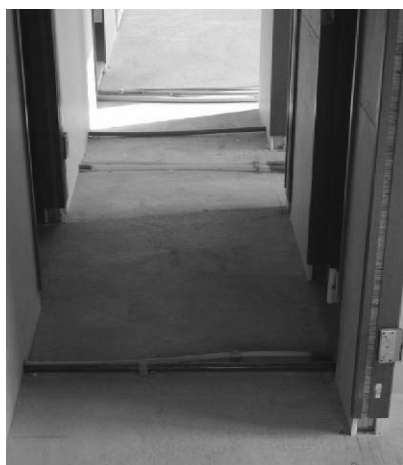
平成14年10月 4日 廊下間仕切り部の 配管貫通部
