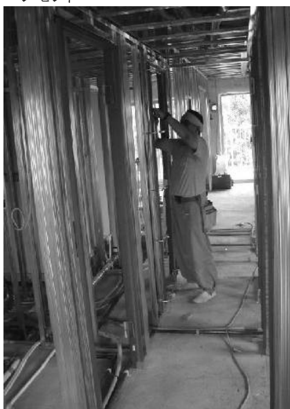
平成14年9月27日 建具枠取付
