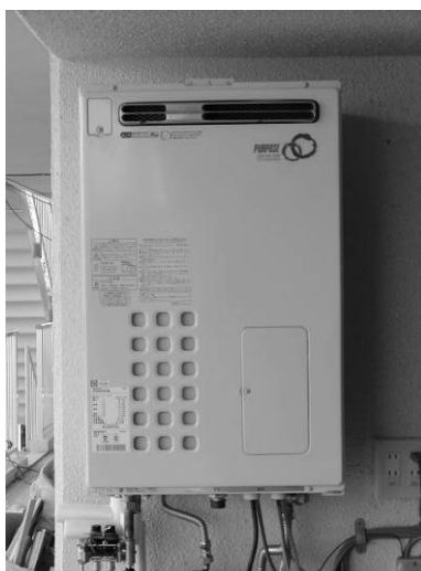
潜熱回収型ガス給湯機
