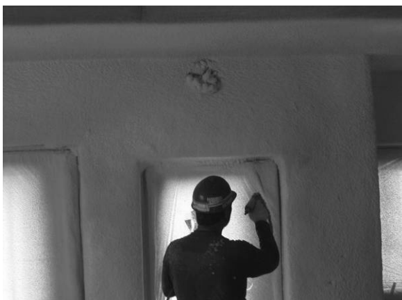
厚さ不足部分の修正
