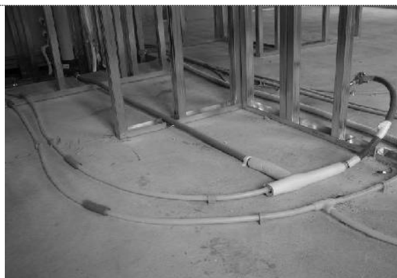
平成14年9月23日 キッチン廻り 給水・給湯配管
