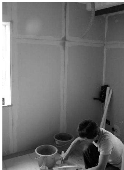
平成14年10月 9日 PBパテ埋め作業
