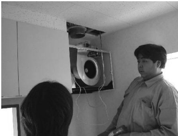
平成14年10月17日 レンジフード設置
