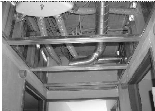
平成14年10月 4日 廊下間仕切り部のダクト貫通部
