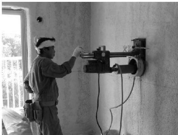
平成14年9月19日 熱流測定用スリーブコア抜き (西妻壁150φ)
