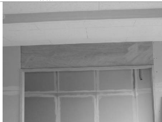
平成14年10月 9日 和室-居間間の欄間(パネル設置状況)
