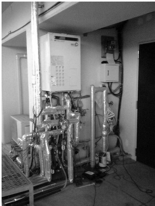
写真 8.4.1 潜熱回収型ガス瞬間式給湯機
