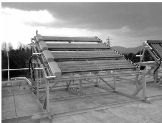
写真 8.4.3 強制循環型太陽熱温水器集熱部
