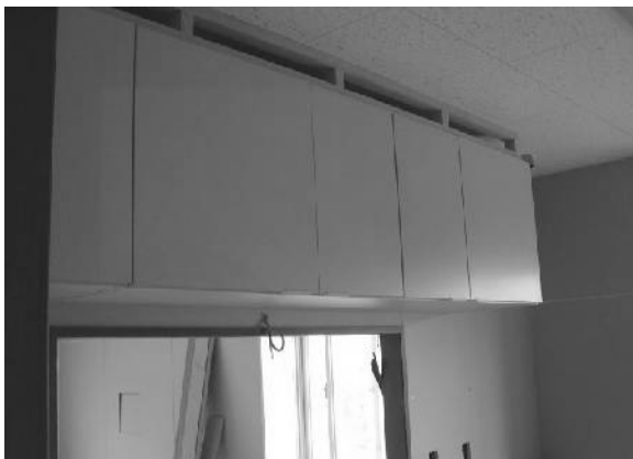
平成14年10月 9日 キッチン吊戸棚設置
