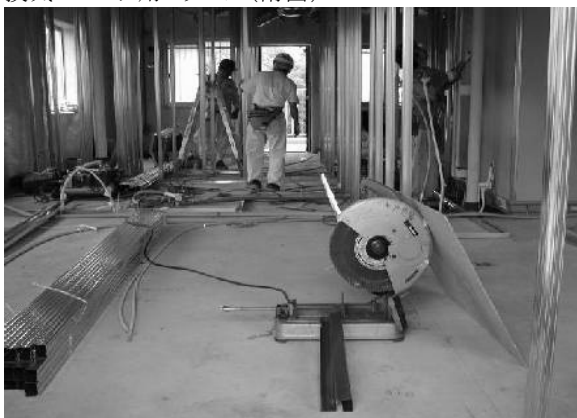
平成14年9月23日 間仕切壁用LGS設置
