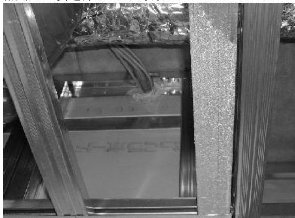
平成14年10月 9日 電気配線貫通部のシール状況
