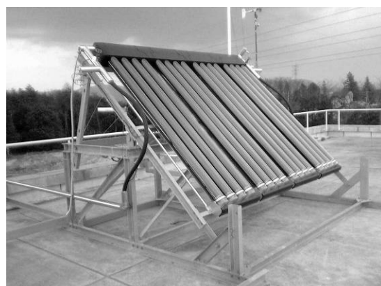
自然循環式太陽熱給湯機
