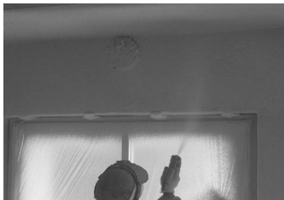
水発泡ウレタン吹付（南面外壁）
