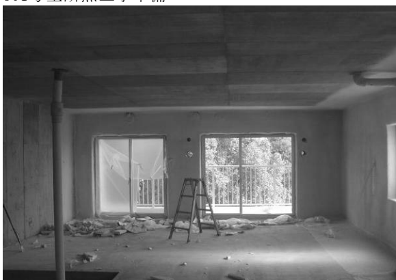
断熱材吹付完了
