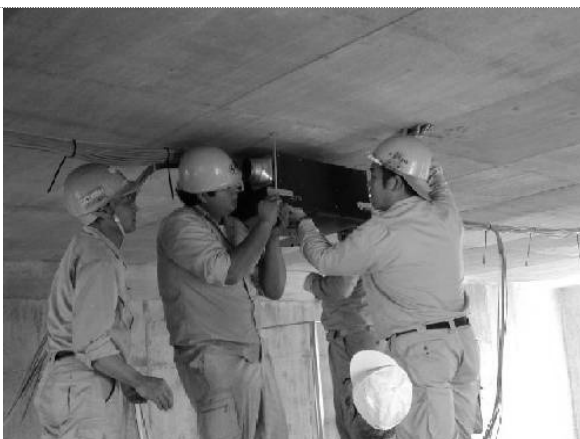
平成14年9月19日 全熱交換型換気装置取り付け
