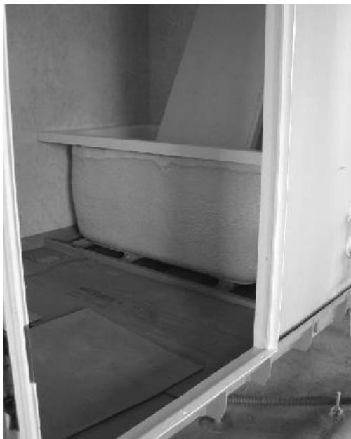
平成14年9月21日 ユニットバス 浴槽設置状況
