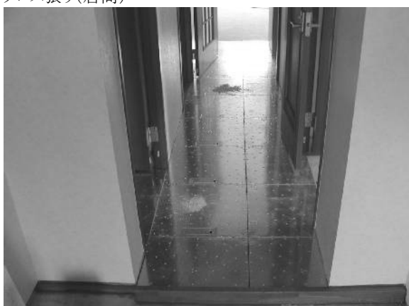
平成14年10月15日 フリーアクセスフロア(廊下)
