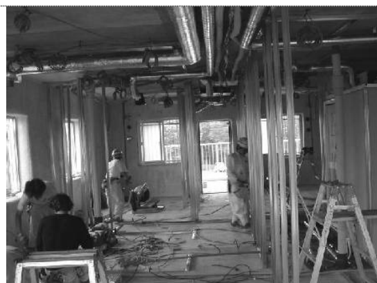
平成14年9月23日 間仕切壁用LGS設置
