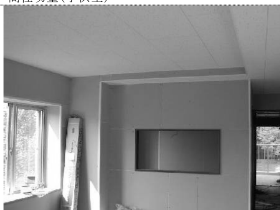
平成14年10月 4日 天井ボード張(居間)
