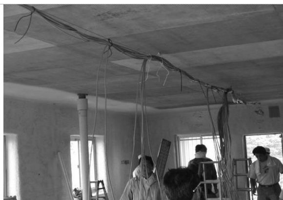
平成14年9月19日 電気配線工事
