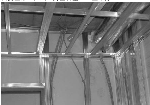
平成14年10月 3日 間仕切壁の立上げ部 ダクト及びケーブルの貫通状況
