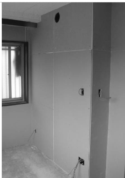
平成14年10月 4日 間仕切壁(子供室)
