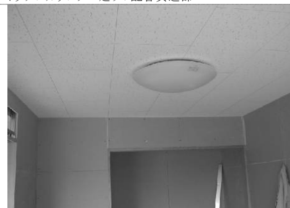
平成14年10月 9日 照明器具取付(和室)
