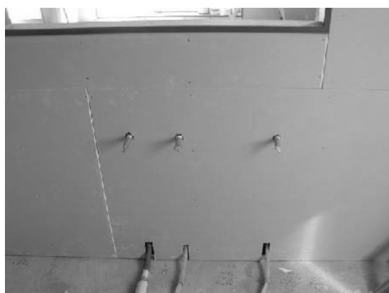
平成14年10月 4日 間仕切壁(キッチン)
