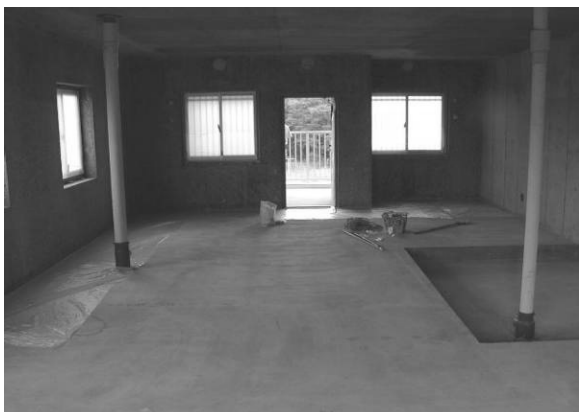
平成14年7月29日 301号室断熱工事準備
