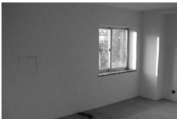
平成14年10月10日 クロス張り(居間)
