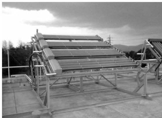
強制循環式太陽熱給湯機
