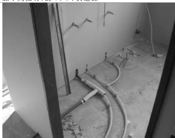
平成14年10月 4日 キッチンカウンター廻りの配管貫通部
