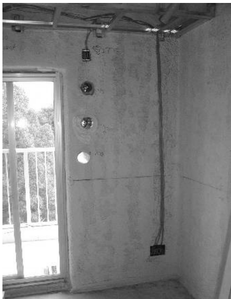
平成14年9月27日 居間(南面コンセント)
