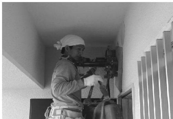
平成14年9月19日 北側外壁コア抜き
