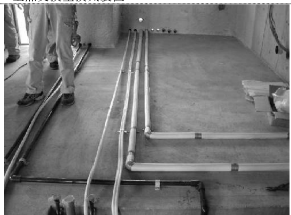
平成14年9月21日 配管工事(北側外壁からの導入部)
