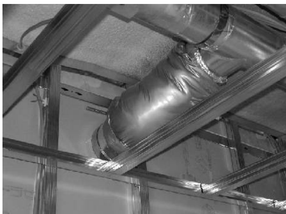
平成14年10月3日 ハイブリッド換気 玄関上部のダクト 間仕切壁の立上げ部
