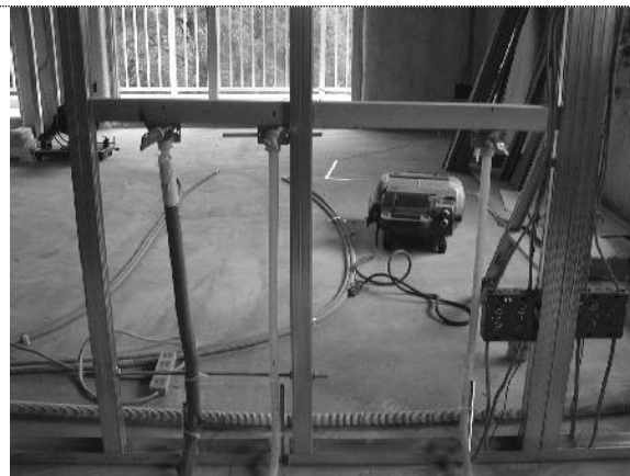
平成14年9月27日 キッチン廻り配管
