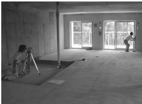
平成14年8月29日 建築墨出し
