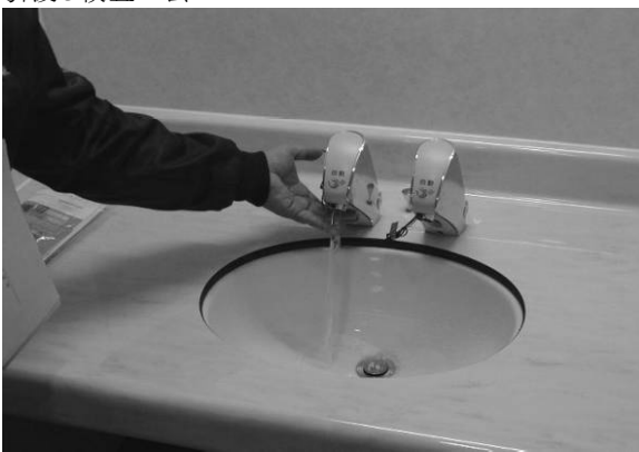
平成14年11月15日 自動水栓動作確認(洗面)
