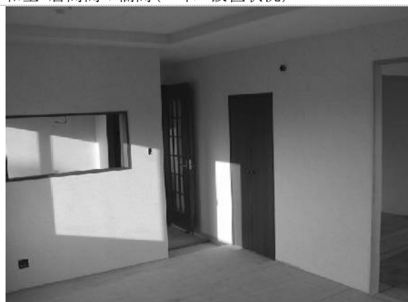
平成14年10月10日 クロス張り(居間)
