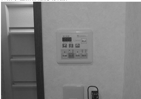
平成14年11月15日 浴室乾燥機動作確認
