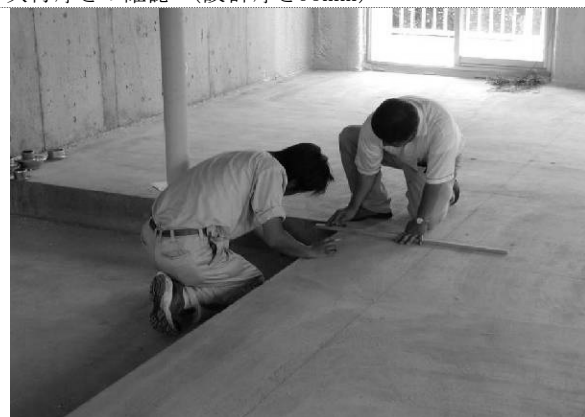
平成14年8月29日 建築墨出し
