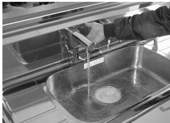
平成14年11月15日 自動水栓動作確認(キッチン流し)
