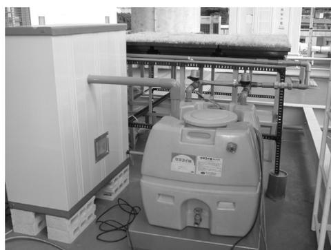
図 7.3.12 除菌装置設置後の緑化システム
