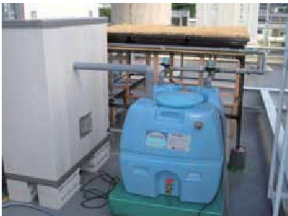
図7.1.5 除菌装置によるレジオネラ属菌の抑制
