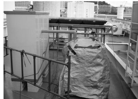
図7.3.7 遮光措置後の貯留水槽
