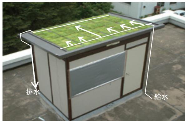
図7.1.8 平面パネル式緑化パレット設置状況
