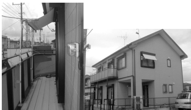
図 4.1.54 日射遮蔽の状況(左:南面 右:東面)
