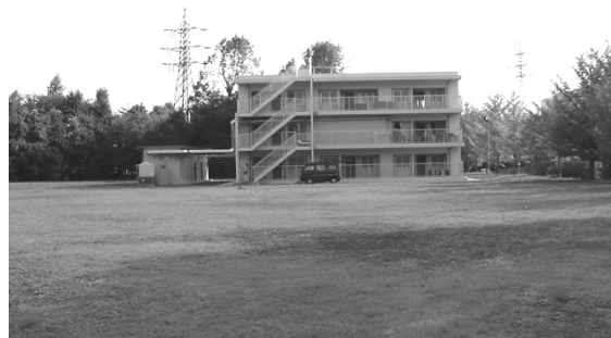
図 4.2.35 集合住宅実験棟外観
