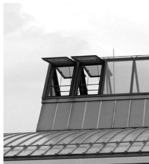
図 4.1.20 上方開放による熱対流方換気
