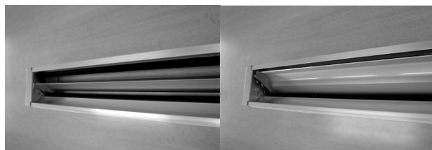
図 4.2.32 換気装置風量制御部 （左：開放、右：風量制御時）
