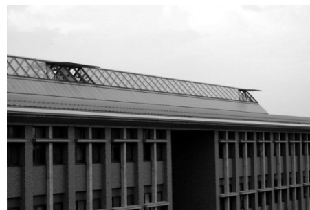
図 4.1.21 上方開放による自然排熱例 (岩手県立大学)
