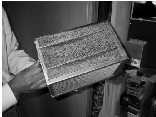
図 4.2.2 熱交換素子の点検
