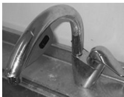
図 3.3.26 止水栓(左:シングルレバー・センサー, 右:足踏み)
