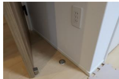
写真Ⅱ.3 磁石により自動作動するドアストッパー
