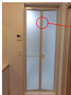
(左) 写真Ⅱ.24 設置の高さ
