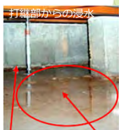
打継に残るセバ金物 浸水状態
