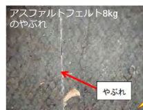
アスファルトフェルト8kgのやぶれ
