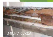
金属水切りの腐食
