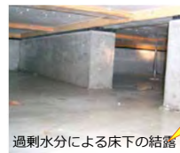
過剰水分による床下の結露
