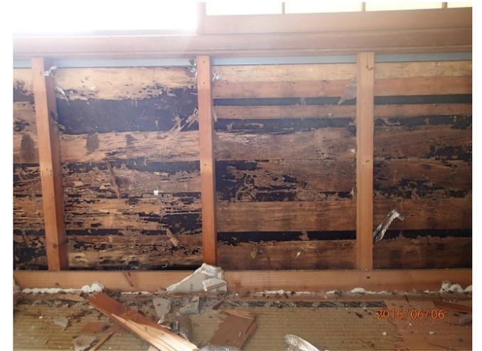
基礎のモルタル仕上げはく離部分から建物に侵入したヤマトシロアリによる1階台所及び2階和室構造部被害
