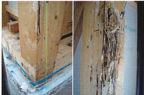
集成柱の被害状況(左:土台と柱の接合部分、右:上部)
