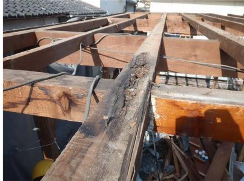
屋根面からの雨漏りによる野地板および小屋梁の腐朽
