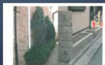
写真 2.5.6 外皮脚部の基礎に接する腐敗花壇の事例
