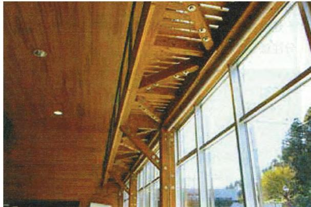
写真 6.5.1 メンテナンス用のヤットウォークの例（静岡県天竜区役所）
