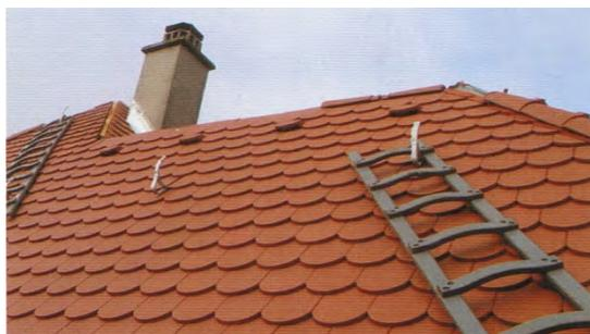
写真 6.5.2 屋根点検用金具を付けたドイツの住宅例（写真提供：岩元創）
