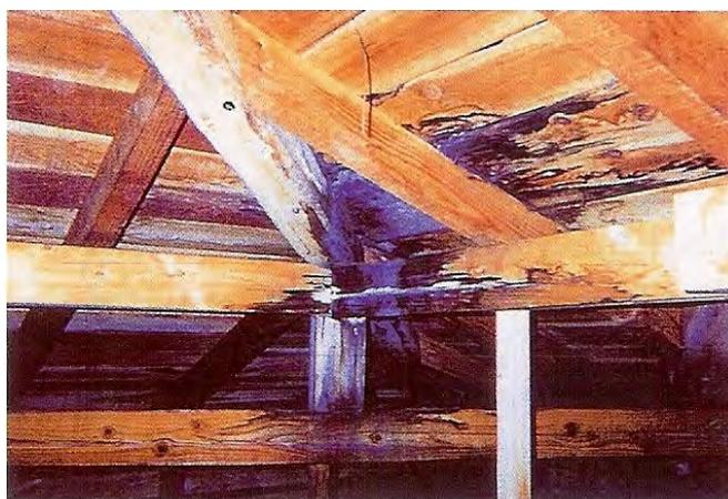
写真 6.3.8 小屋裏漏水箇所の様子
