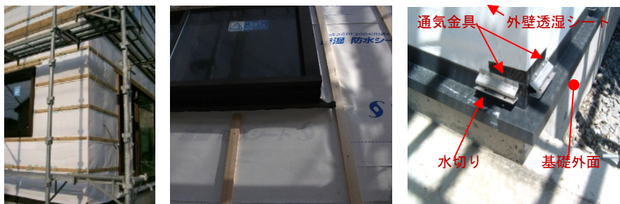
木製の通気胴縁（左：横胴縁 右：縦胴縁の施工事例） 通気金具の施工事例
