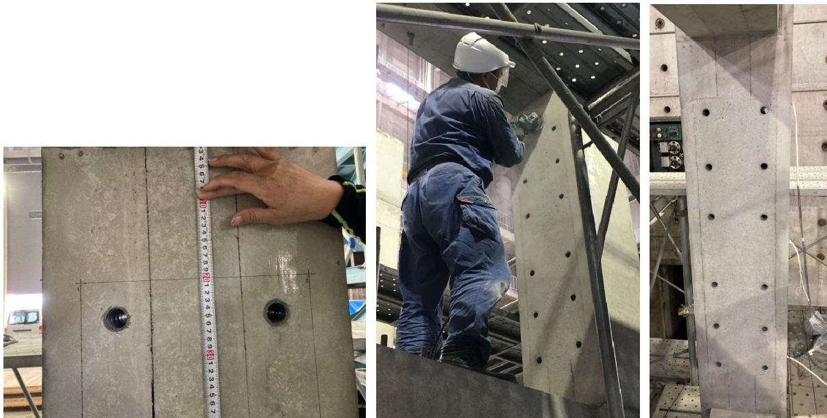
写真 2-4 墨出し、目荒らし
