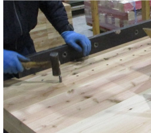
(a) 鉛直接合部取り付け用のスリット孔の加工
