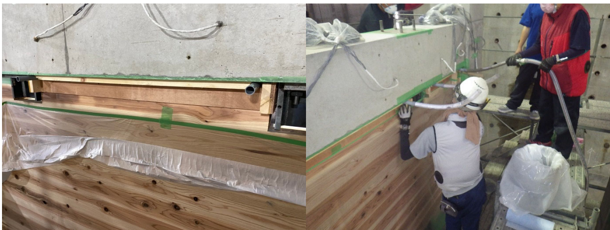
写真 2-10 CLT 耐力壁周囲への無収縮モルタルの充填(3 回目)
