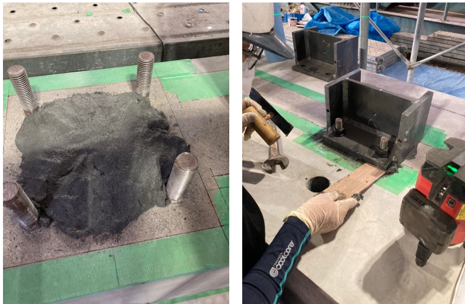
写真 2-6 滑り止めの設置 (WA 試験体)
