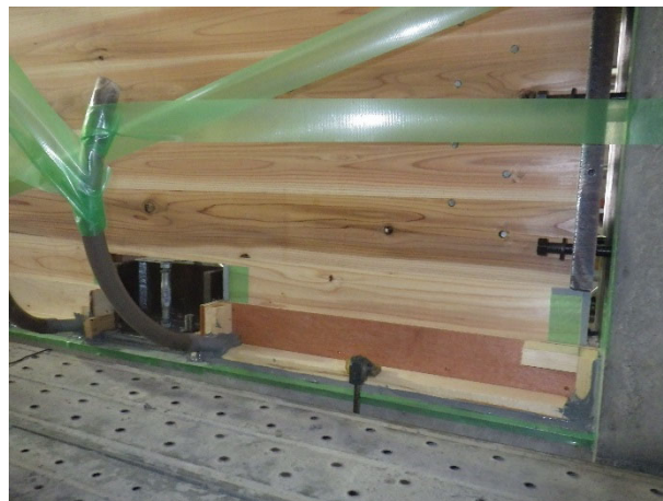
写真 2-8 CLT 耐力壁周囲への無収縮モルタルの充填(1 回目)
