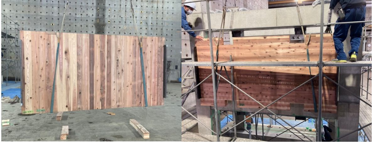
(a) クレーンによる CLT 耐力壁の吊り込み
