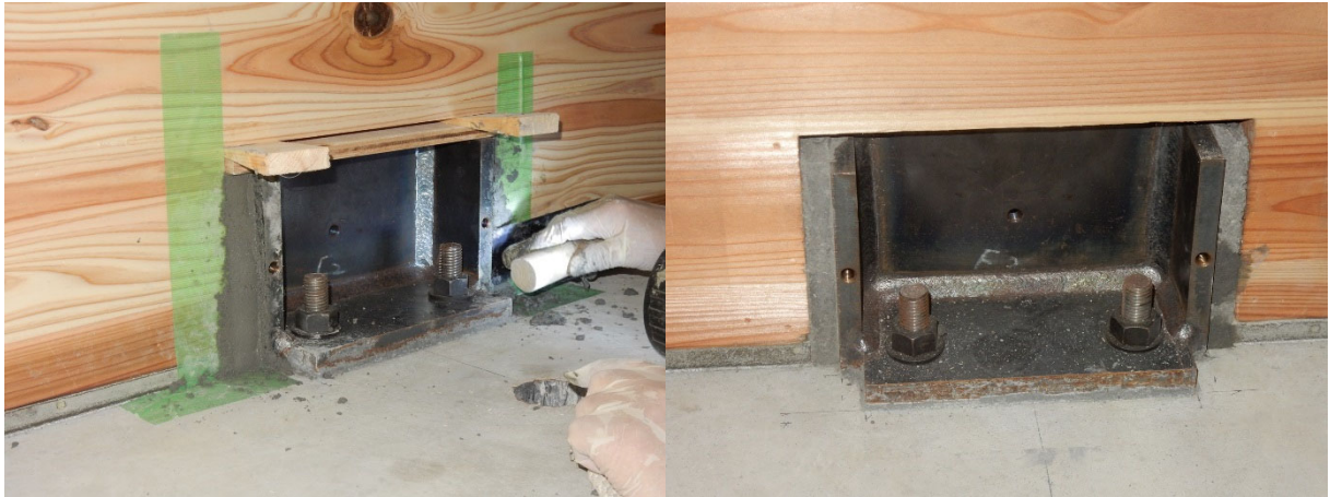
写真 2-11 CLT 耐力壁－滑り止め間の不陸調整モルタルの充填
