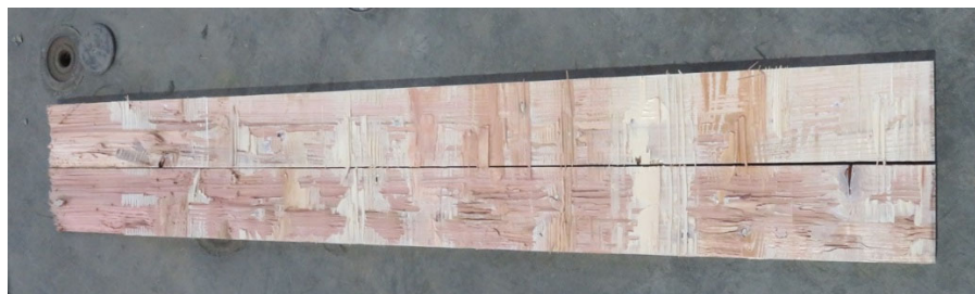
写真 2-45 2F の CLT 耐力壁における最外縁ラミナの脱落 (R=1/33)
