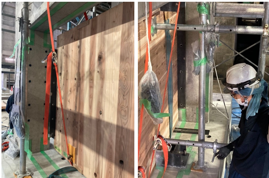
(b) ラッシングベルトを用いた CLT 耐力壁の RC ラーメン内への挿入
