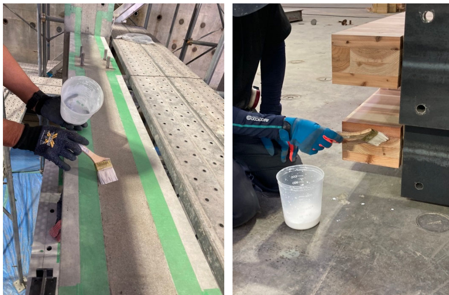
写真 2-5 プライマー塗布の状況
