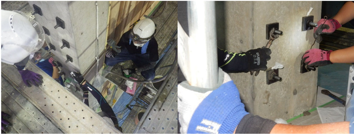
写真 2-9 CLT 耐力壁周囲への無収縮モルタルの充填(2 回目)
