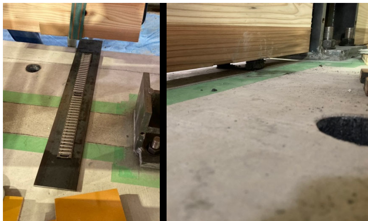
(c) 挿入時に用いたリニアスライダーと不陸調整モルタルによるスペーサー 写真 2-7 CLT 耐力壁の設置
