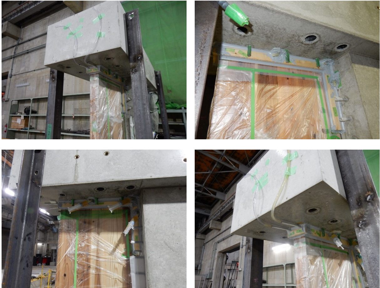
写真 2-10 2 回目のエポキシ樹脂の充填時の様子
