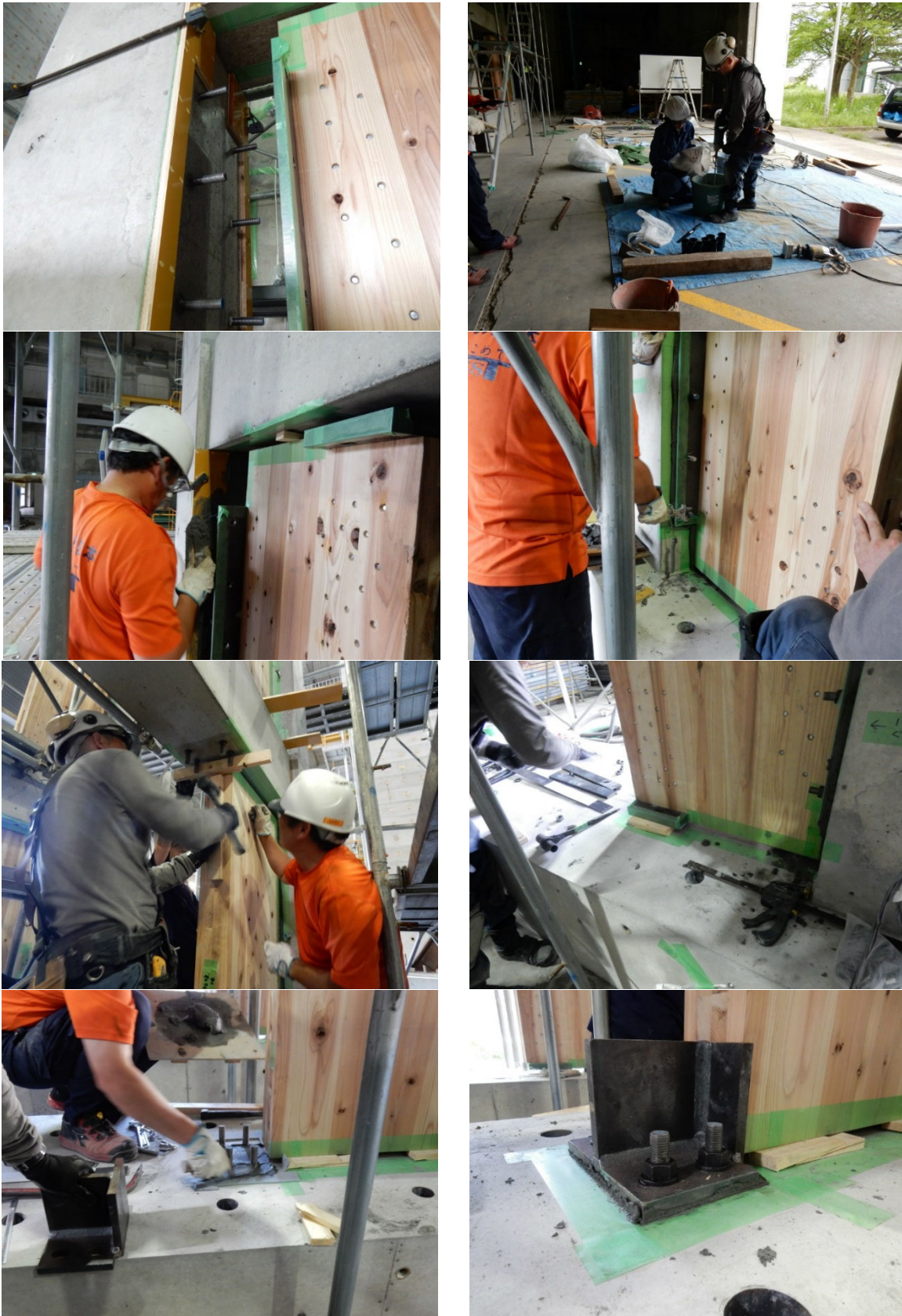
写真 3-4 RC 柱への不陸調整目地用型枠の固定、モルタル練り、鉛直目地のモルタル充填、袖壁設置
