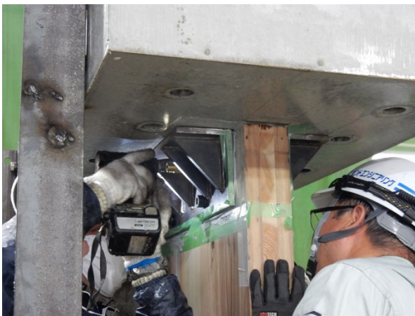
写真 2-13 水平接合部の接着時の様子
