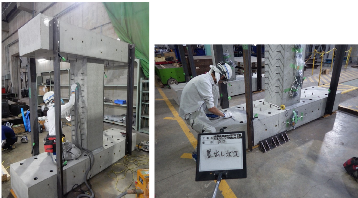
写真 2-1 目荒らし、墨出し
