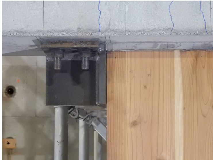
写真 3-26 滑り止め—CLT 袖壁間の離間 (R=1/400)
