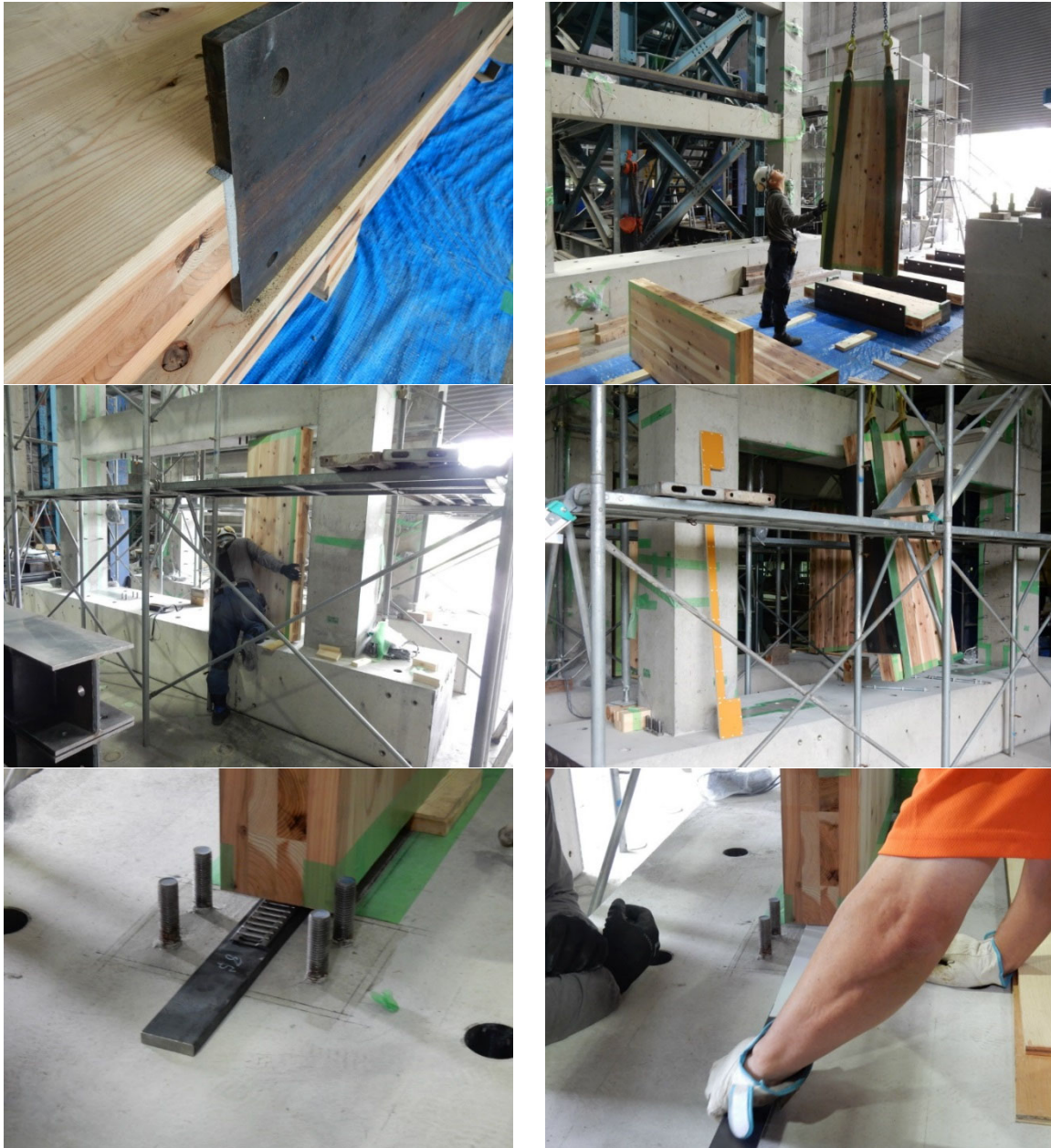
写真 3-3 CLT 袖壁の仮設置、水平目地下部に挿入したリニアスライダー
