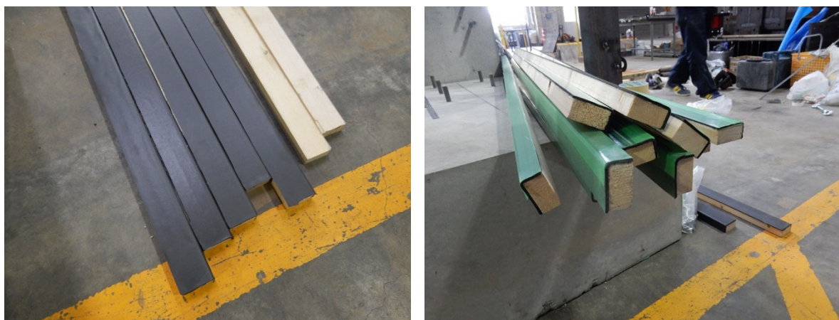
写真 2-2 型枠の表面処理(ゴムスポンジ(漏れ止め)+養生テープ(脱型のしやすさ))
