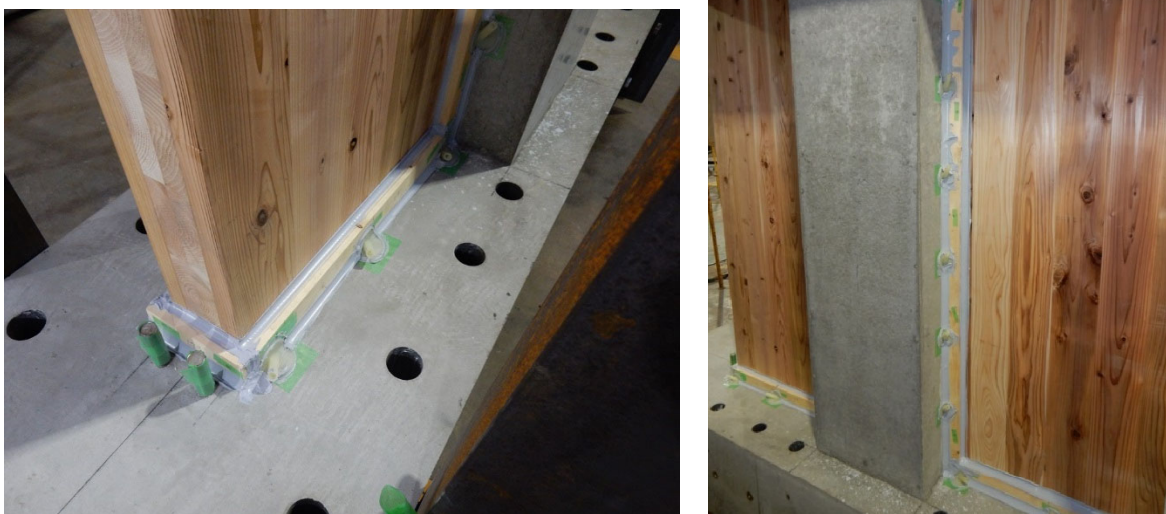
写真 2-6 エポキシ樹脂の注入口と目地材の設置
