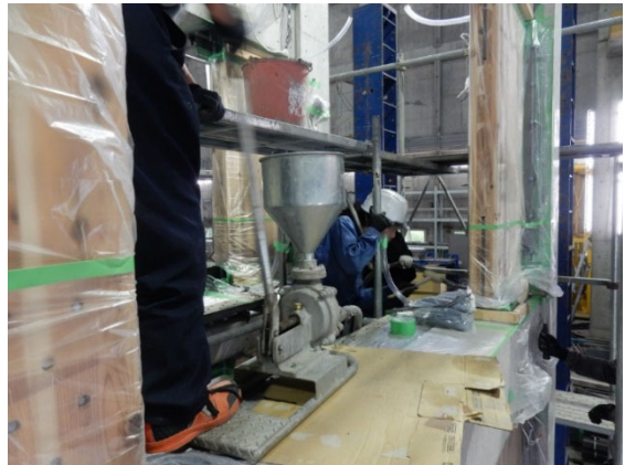
写真 3-6 アンカーボルトの養生、水平目地用型枠およびその固定、水平目地のモルタル充填
