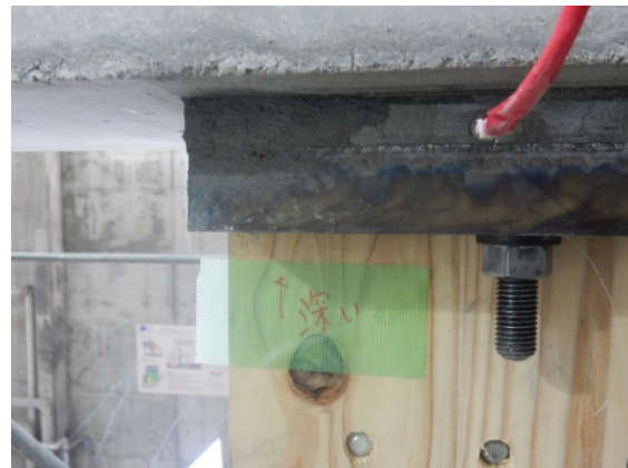
写真 3-7 脱型後の水平目地のモルタル充填状況、補修
