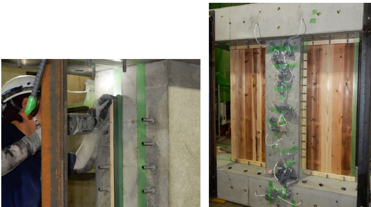
写真 2-4 RC 柱への型枠の固定、CLT 袖壁の型枠への固定
