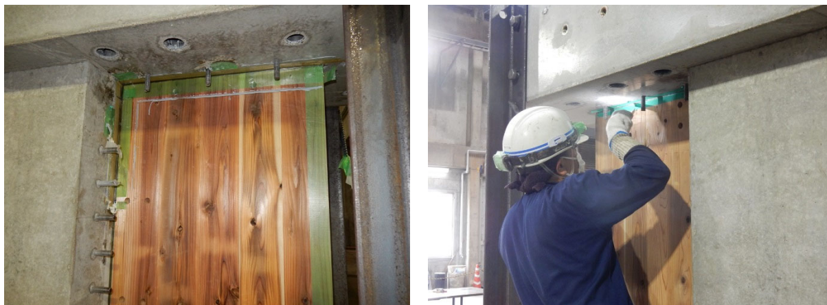
写真 2-12 2 回目のエポキシ樹脂充填後の脱型時の様子
