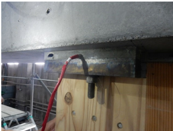
写真 3-7 脱型後の水平目地のモルタル充填状況、補修
