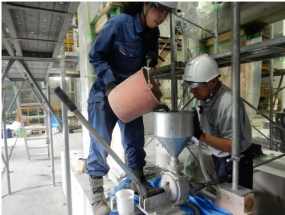
写真 3-6 アンカーボルトの養生、水平目地用型枠およびその固定、水平目地のモルタル充填
