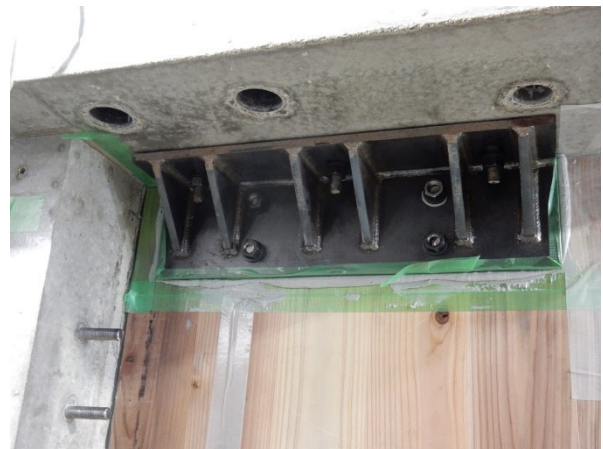
写真 2-13 水平接合部の接着時の様子
