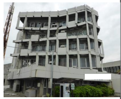
写真6 大きく損傷したエキスパンションジョイント
