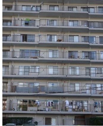
写真5 大きく損傷したベランダ側の非耐力壁
