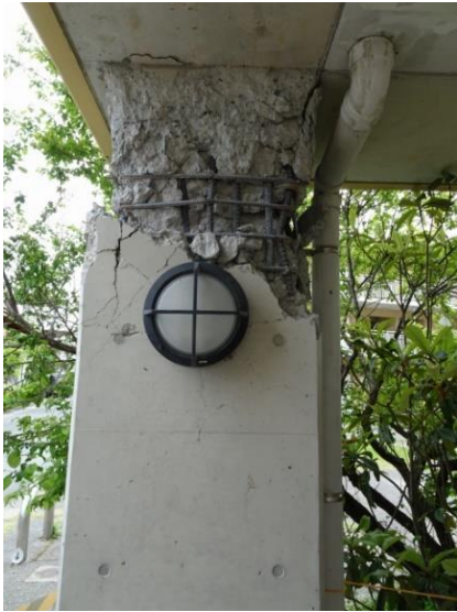
写真1 大きく損傷した柱頭部
