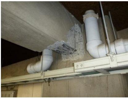
写真1 大きく損傷した柱頭部
