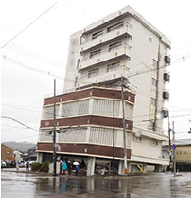
写真 7.1 建物全景（南東側から撮影）
