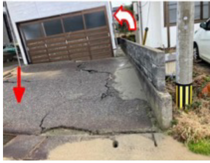
d) 傾斜した住宅
