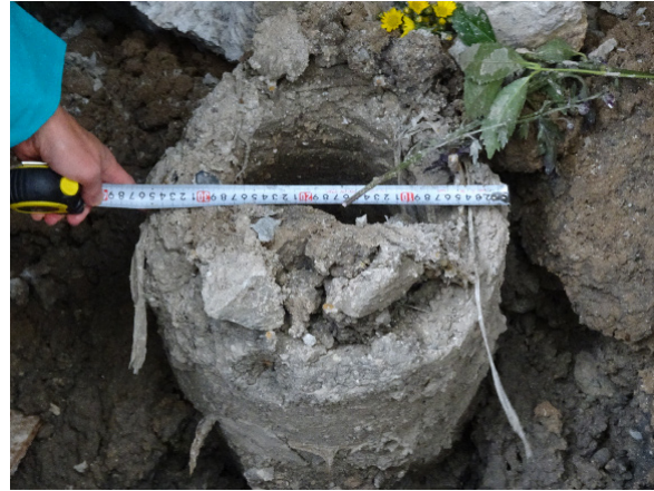
b) 杭の寸法形状の確認状況
