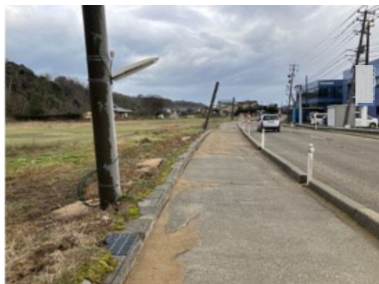
写真 5.6 県道 8 号の状況（写真左側が砂丘であり、県道 8 号沿いは砂丘に隣接する低地）
