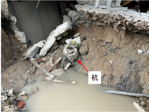
a) 地表面の状況
