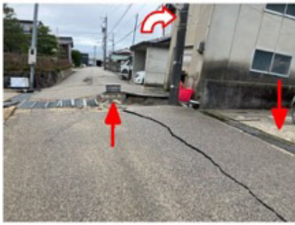
c) 浮き上がった地下埋設物と傾斜した建物
