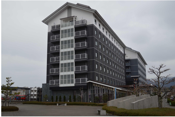
写真 10.1 E ホテル西館（紙面の手前側の建物）の傾斜
