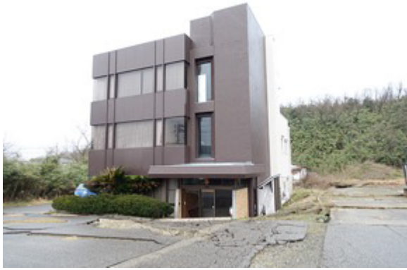
写真 5.2 3階建ての建物
