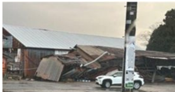
写真 6.4.4 穴水町川島の工場社屋の倒壊
