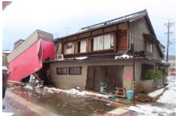
写真 6.4.14 倒壊した木造店舗併用住宅
