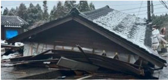
写真 6.3.16 写真 6.3.16 の近傍で2023年地震時に倒壊を免れたが今回倒壊に至った家屋
