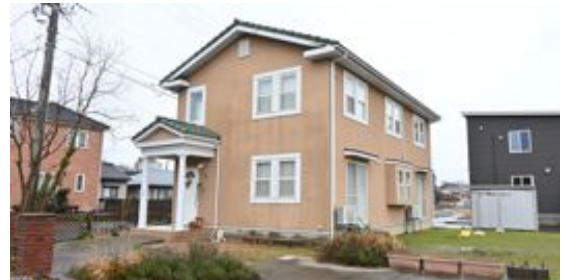
写真 6.9.4 七尾市の 2 階建枠組壁工法住宅 (2000 年竣工)
