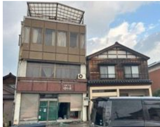
写真 6.1.8 隣家と衝突した可能性がある住宅
