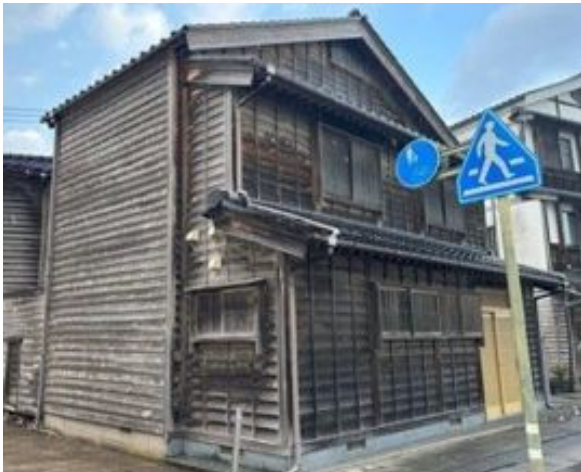
写真 6.1.5 被害軽微に見える比較的古い木造家屋
