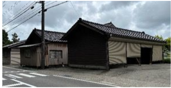
写真 6.3.15 写真 6.3.16 の近傍で2023年地震時に倒壊を免れた家屋 2) (2023年5月撮影)
