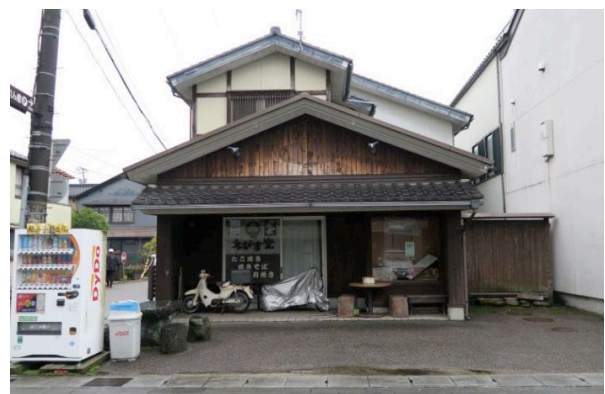
写真 6.7.10 外観上無被害の木造店舗併用住宅
