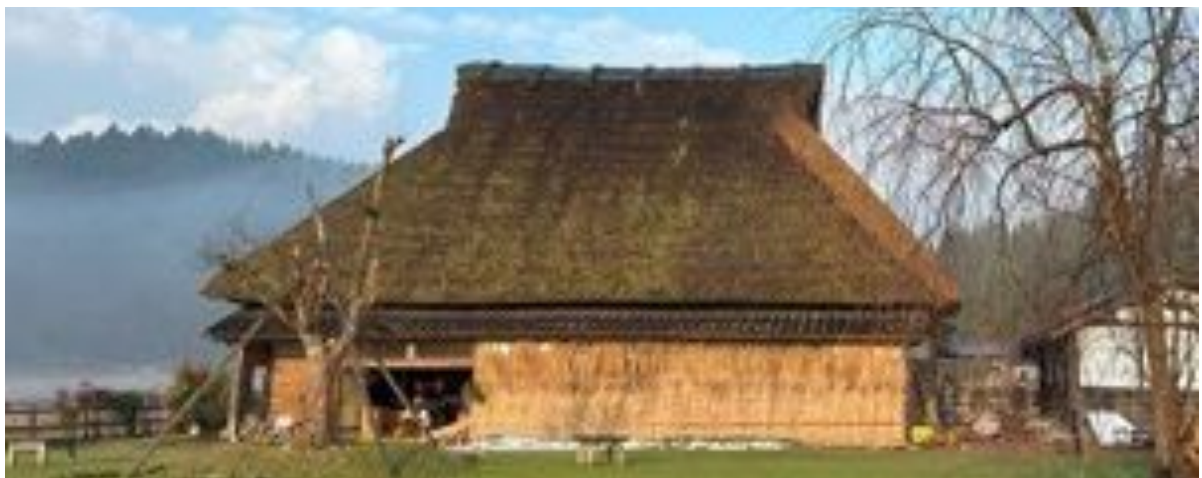
写真 6.1.13 被害軽微に見える藁葺き屋根の民家
