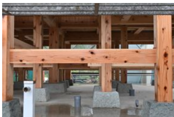
写真 6.7.4 写真 6.7.3 の束と礎石部分
