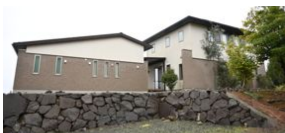
写真 6.7.5 外観上無被害の木造住宅
