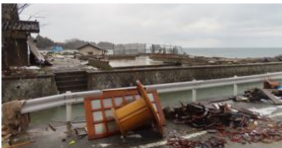
写真 6.6.5 津波により流失した木造住宅 2
