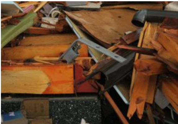
写真 6.3.21 写真 6.3.19 のホルダウン金物
