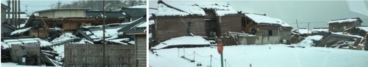
写真 6.2.12 門前町黒島の倒壊家屋群
