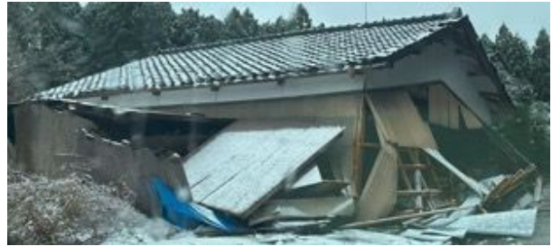
写真 6.3.16 写真 6.3.16 の近傍で2023年地震時に倒壊を免れたが今回倒壊に至った家屋
