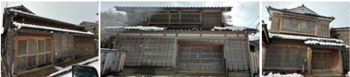
写真 6.2.15 建築年が古い割に被害が軽微の家屋
