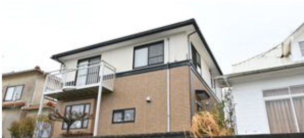
写真 6.9.3 七尾市の 2 階建枠組壁工法住宅 (1996 年竣工)
