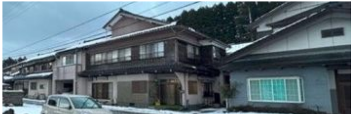
写真 6.5.3 外観上無被害に見える木造家屋
