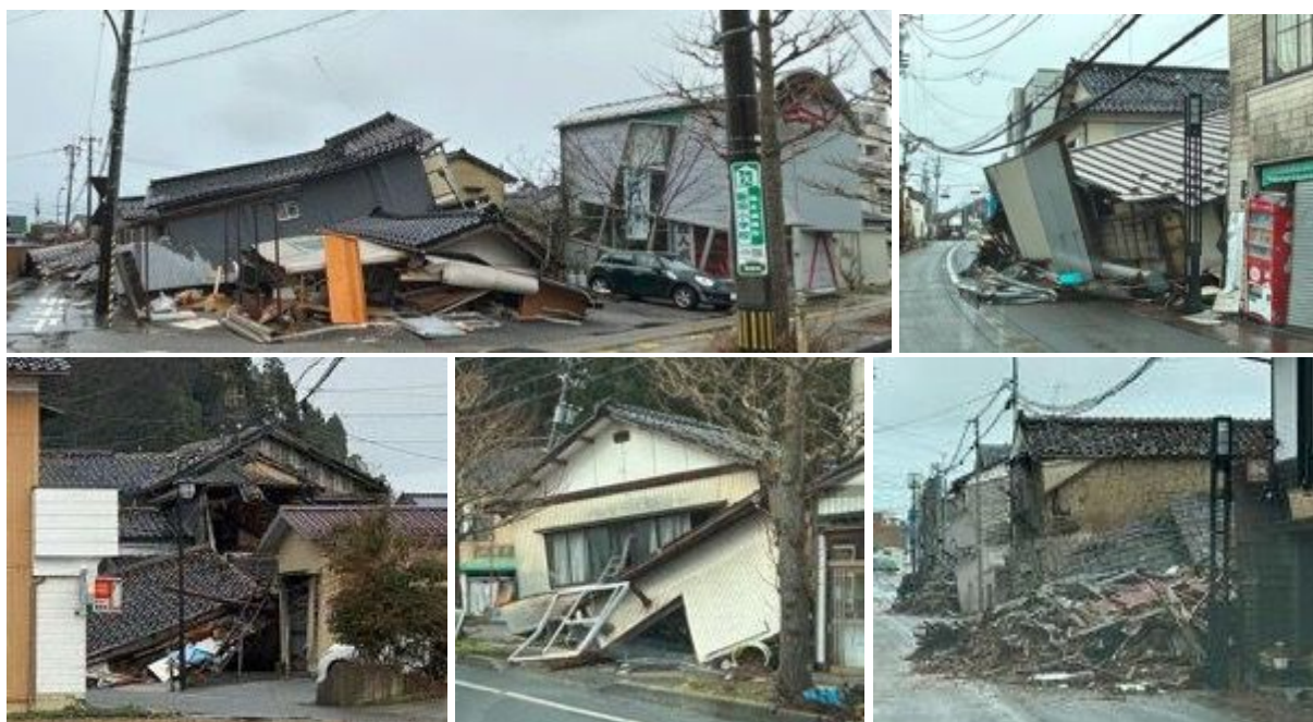
写真 6.3.1 珠洲市役所近辺で倒壊した木造家屋群（珠洲市飯田町）
