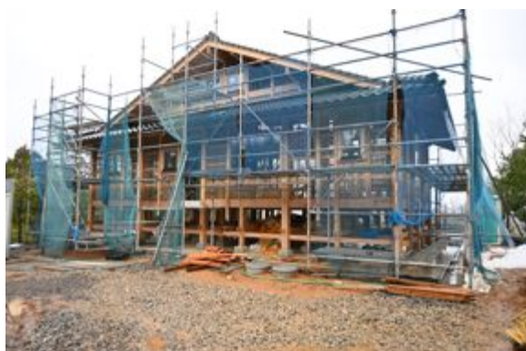
写真 6.7.3 建設中の石場建て木造住宅
