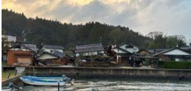
写真 6.4.1 穴水町曾福の倒壊家屋群
