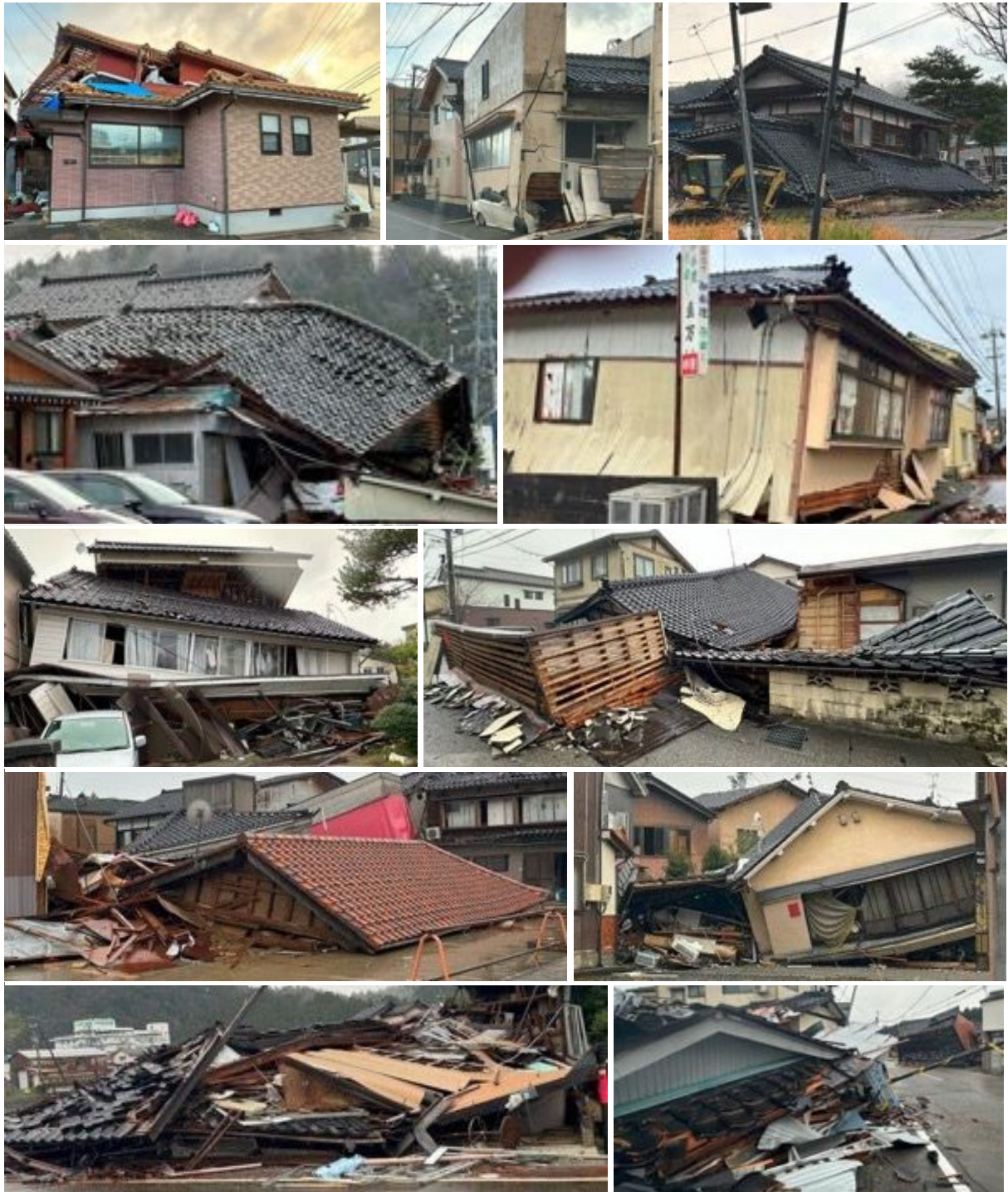
写真 6.4.7 穴水町大町の倒壊家屋群
