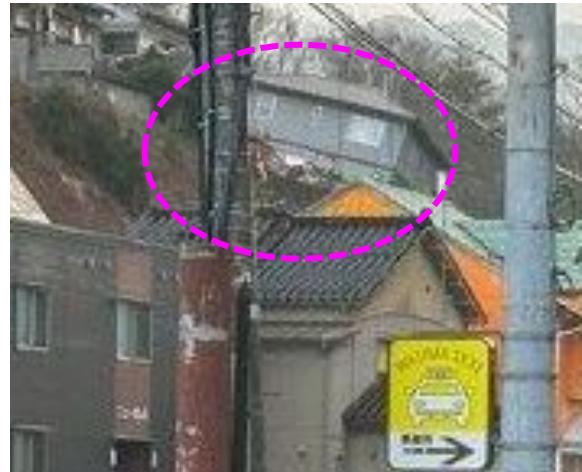
写真 6.1.6 斜面崩壊による被害の可能性がある家屋
