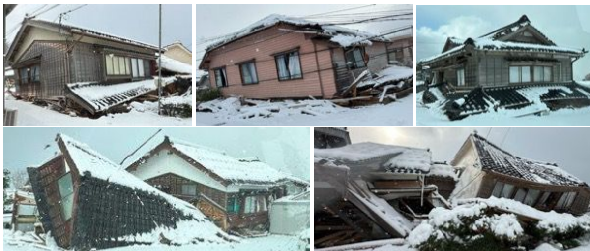
写真 6.2.8 門前町道下・館の倒壊家屋群
