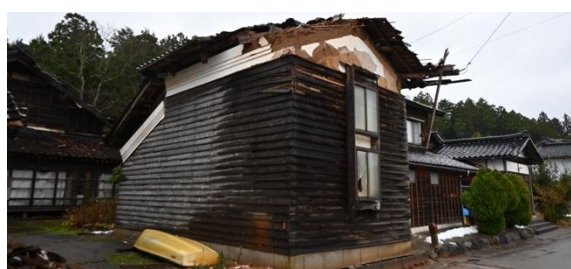
写真 6.7.6 土蔵の被害
