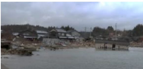
写真 6.6.3 津波により湾に流出した木造住宅
