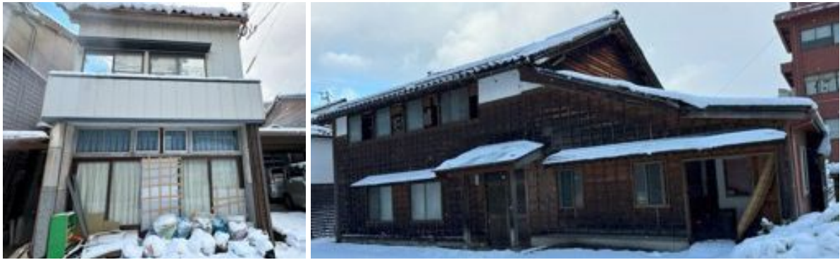
写真 6.2.4 建築年が古いと見える割に外観上被害軽微と見受けられる木造家屋
