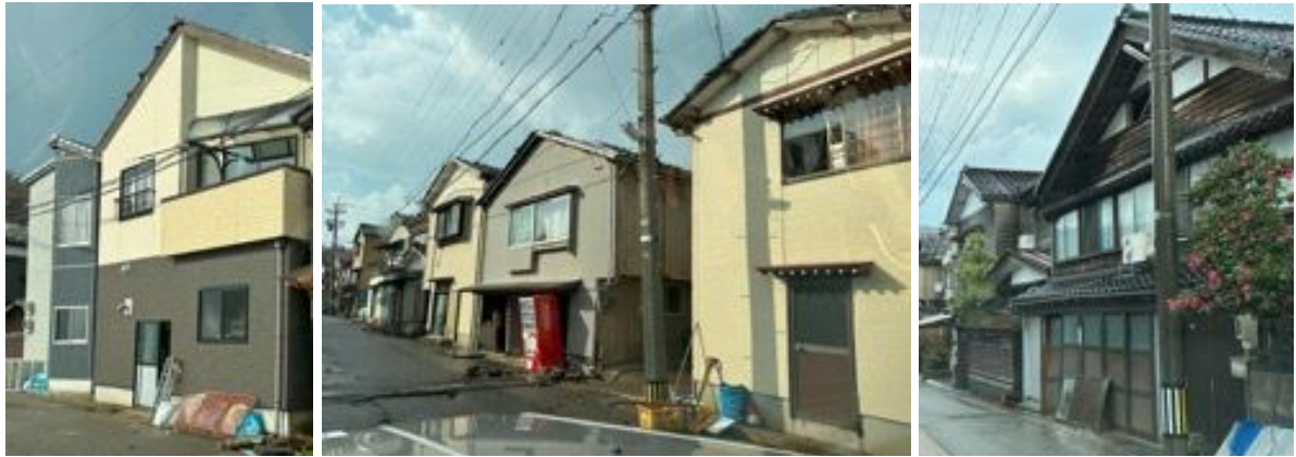
写真 6.1.11 比較的被害が軽微と見受けられる木造住宅（鳳至町）
