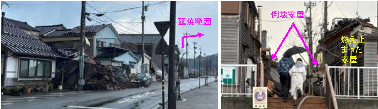
写真 6.1.3 延焼範囲近傍で倒壊していた家屋
