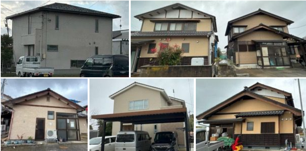
写真 6.3.8 新耐震基準施行後の建築とみられる無被害又は被害軽微の家屋
