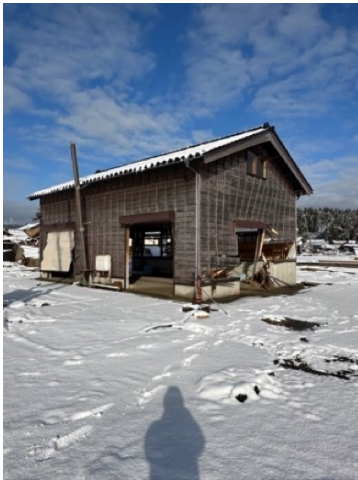
図 6.2.6 流失を免れた建築物(1)
