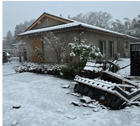
図 5.4.9 住宅に隣接した門の倒壊
