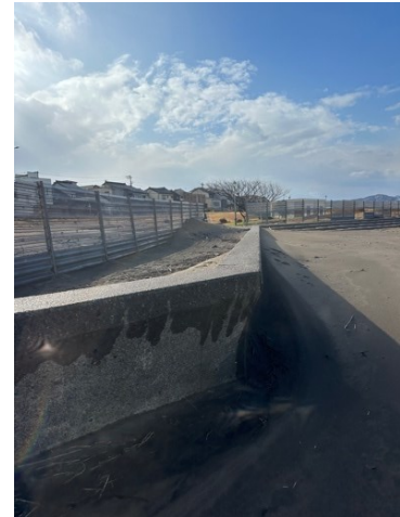
図 4.2.5 損傷のない防砂柵 (海側に堤防あり)
