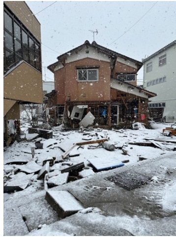
図 5.3.2 開口部の損傷
