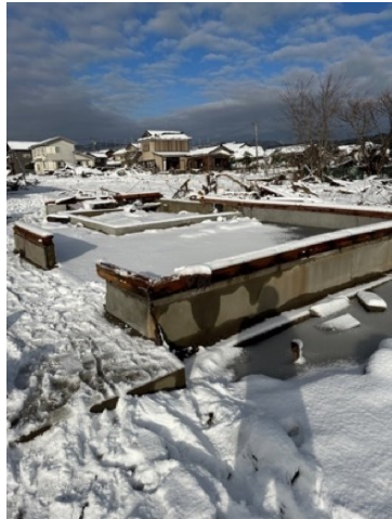
図 6.2.4 建築物の流失(2)
