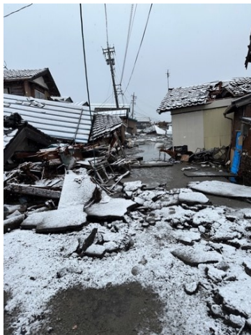
図 5.2.6 鶺鴒漁港周辺の地震被害状況
