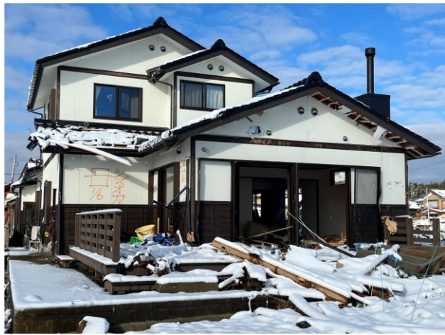
図 6.2.7 流失を免れた建築物(2)
