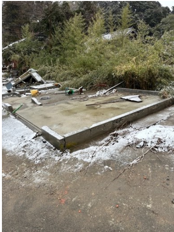
図 5.5.1 流失した建築物
