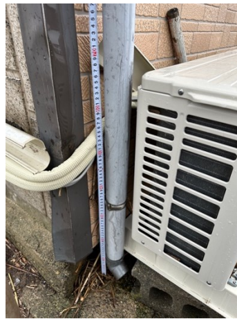
図 4.1.5 津波の痕跡高さ
