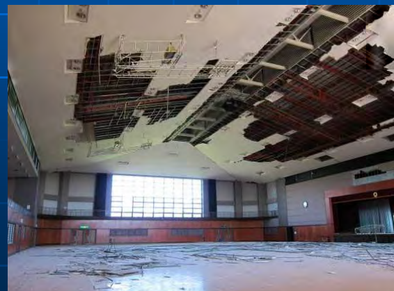
山形架構の屋根面に平行な天井
