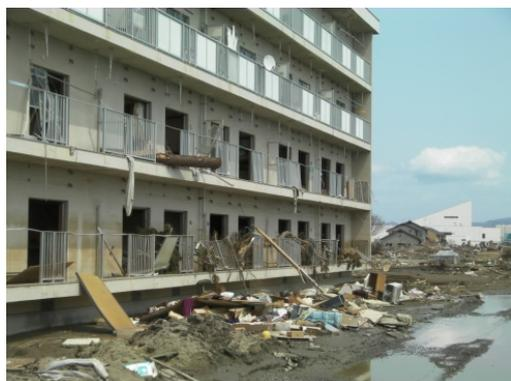
写真 3-3 2階開口部まで破損
