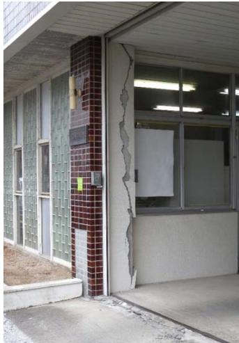
写真 3-41 仕上げの剥落
