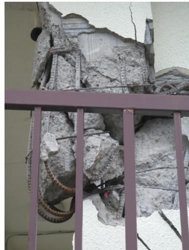
写真 3-39 2階柱のせん断破壊
