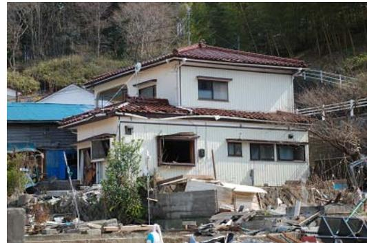
写真 4.3-8 2階床上程度まで浸水したと推察される住宅（女川町南側斜面）
