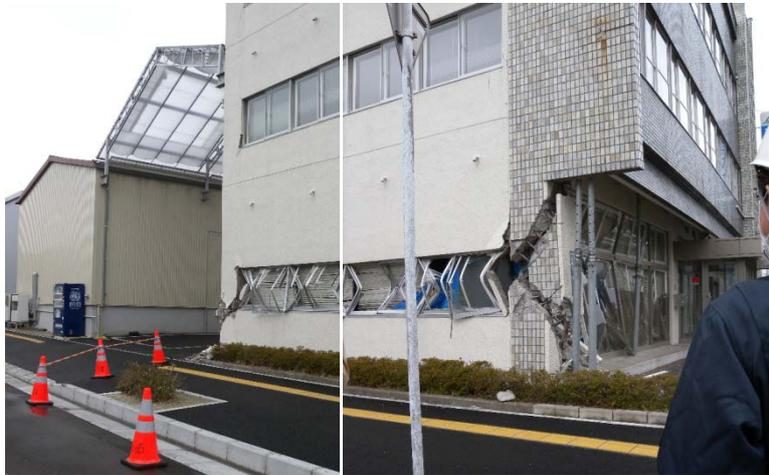
写真 3-36 東側構面の柱の被害状況
