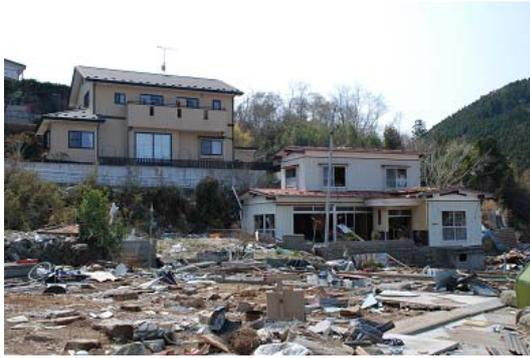
写真 4.3-5 市街地南側斜面上の木造住宅。右側の建物は2階床程度まで浸水、左上の建物は顕著な浸水は受けていないものと推察される（女川町）
