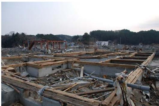
写真 4.3-1 鉄筋コンクリート造布基礎と土台を残して流失した木造住宅の痕跡(南三陸町)
