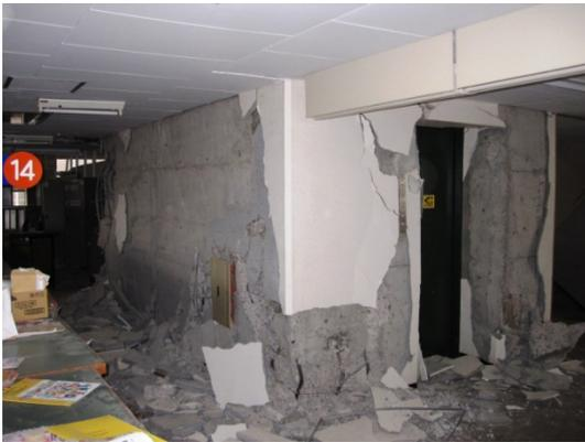
写真 3-48 コア壁の破壊
