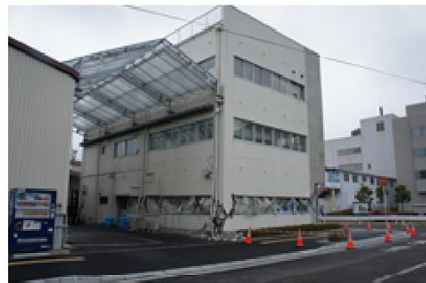
写真 4.2-11 1階が大破したRC造
