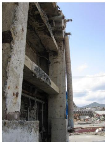
写真 3-16 曲げの残留変形が残る杭が基礎にぶら下がっている
