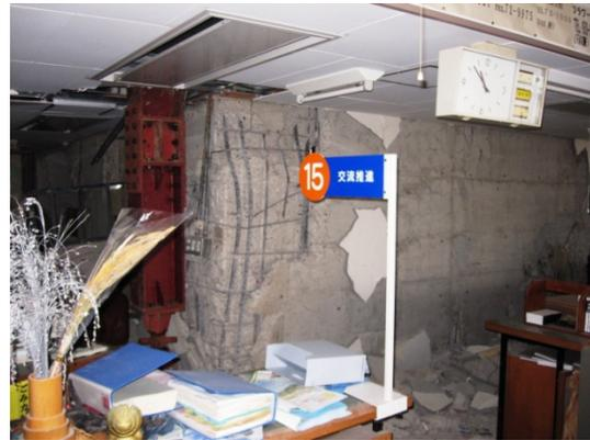
写真 3-49 耐震壁側柱の主筋の座屈
