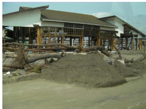
写真 3-4 外装の破損状況
