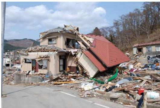
写真 4.3-9 漂流した住宅の2階部分が衝突した木造住宅（女川町）
