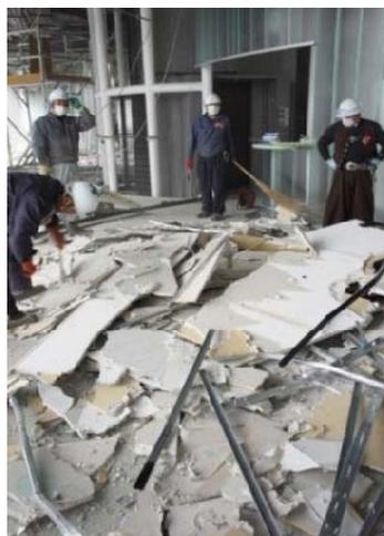
写真 4.2-21 天井材の落下
