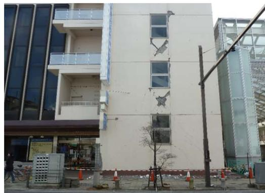
写真 3-54 壁の縦開口隅角部間のせん断ひびわれ
