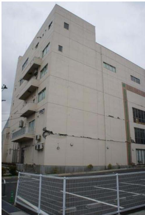
写真 4.2-18 大破した RC 造 (須賀川市)
