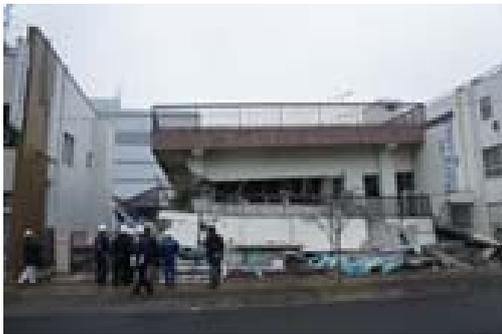
写真 4.2-10 1階が崩壊したRC造
