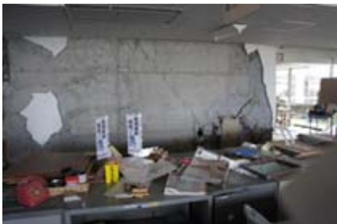
写真 4.2-12 せん断破壊したコア壁
