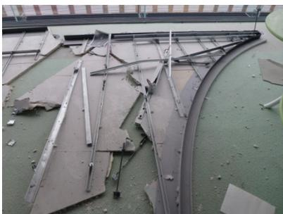
写真 3-29 落下した天井パネル
