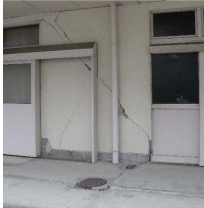
写真 3-40 鉄筋コンクリート部材のひび割れ
