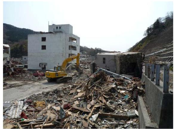
写真 4.4-7 津波で転倒・流された旅館（RC 造 4 階建て）：基礎底に杭の一部が残る；本写真の右側は、病院が建つ高台につながる傾斜面である。
