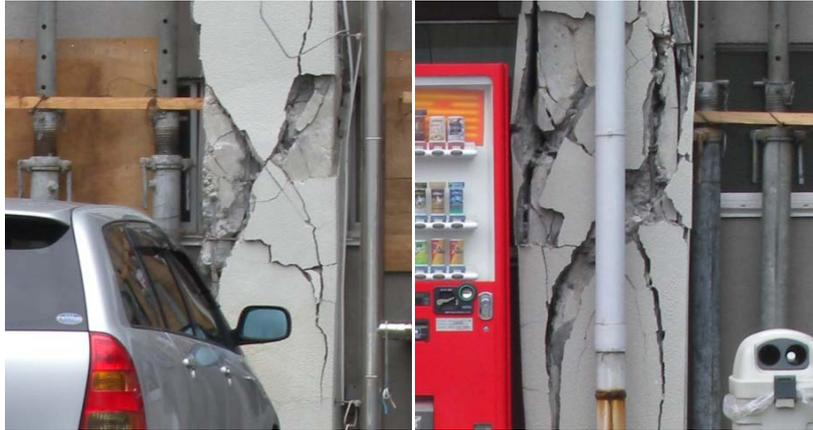
写真 3-37 柱の被害及びその周辺
