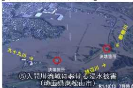
【令和元年東日本台風】
