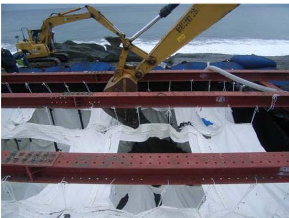
写真-1 土砂の投入状況
