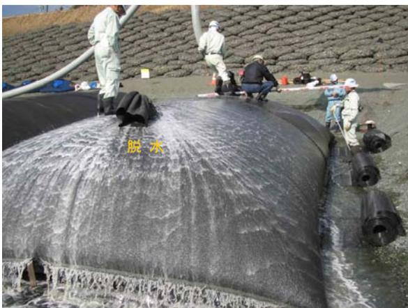
写真-12 中詰め材の充填と脱水状況
