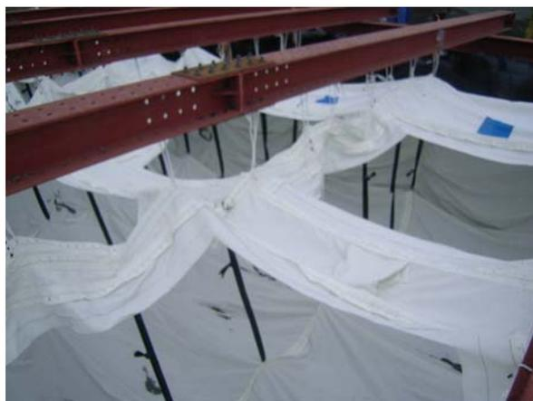
写真-2 ベルト連結構造
