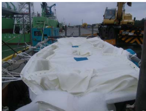
写真-2 袋体吊下げの様子
