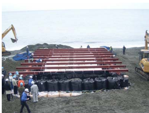
写真-6 作業全景
