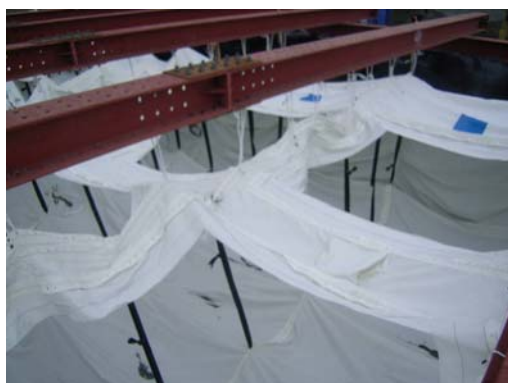
写真-5 ベルト連結構造
