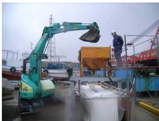
写真-1 ホッパーを用いた粗砂の中詰め方法
