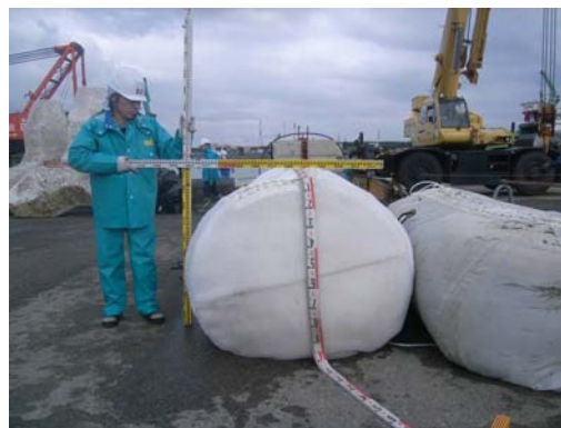
写真-3 袋詰め工
