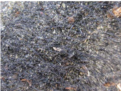
写真-13 現地におけるシートの状況
