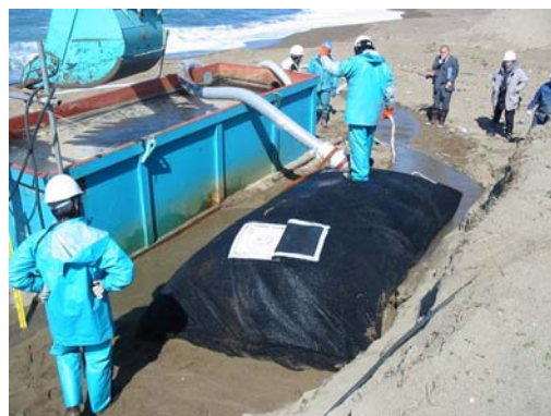
写真-8 中詰め作業状況
