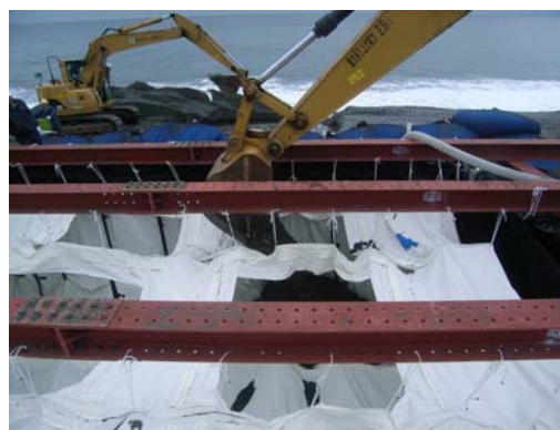
写真-4 バックホウにより直接投入する方法
