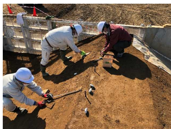
写真 4-3 傾斜計センサー（左）とカメラ（右）設置状況
