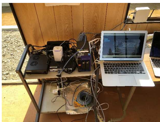
写真 4-4 現地サーバー及びゲートウェイ装置
