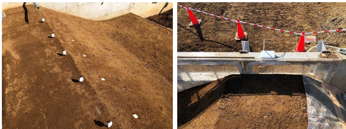
写真 4-1 傾斜センサー（左）と中継器（右）設置状況
