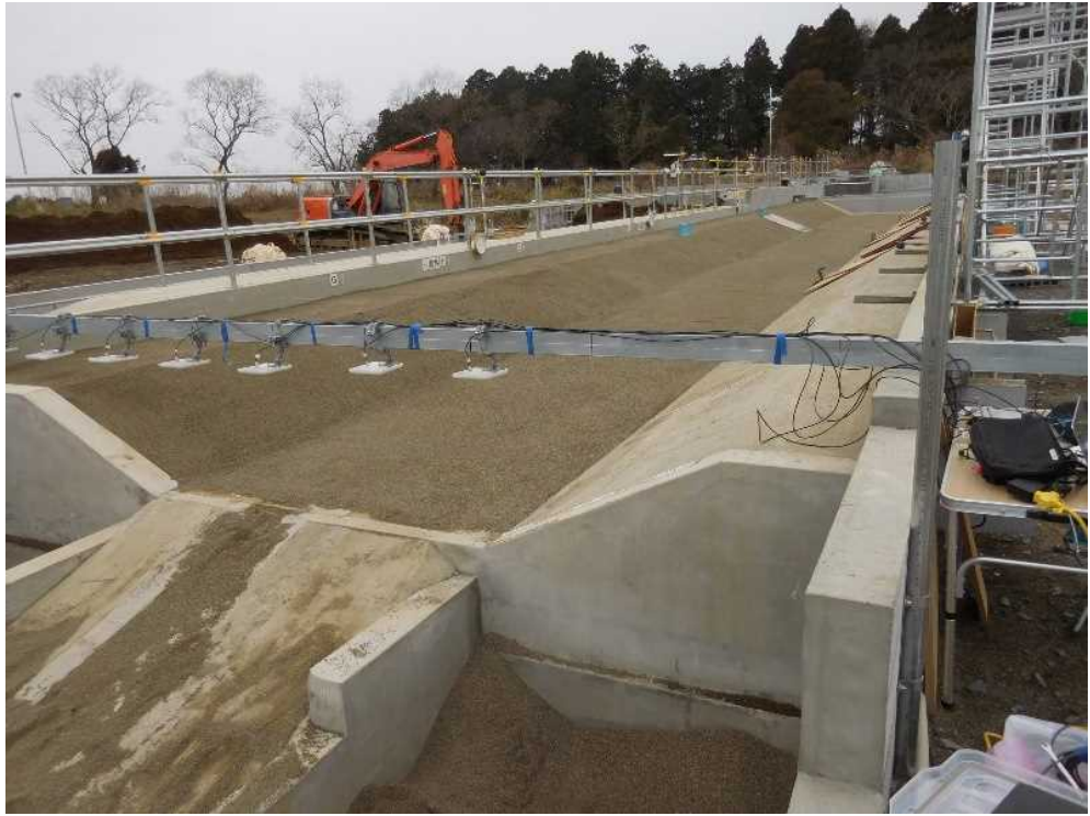
図 23 完成した試験水路
