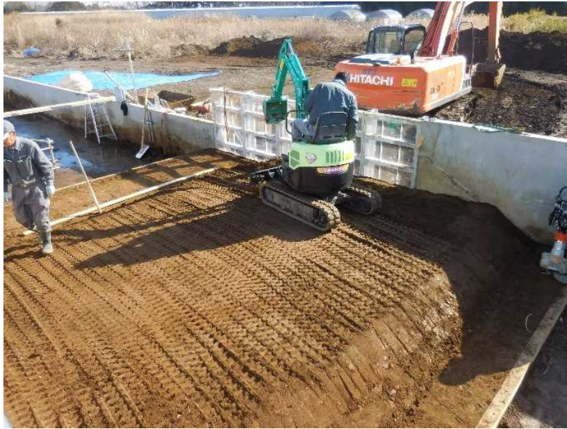
図 19 締固め作業(2)
