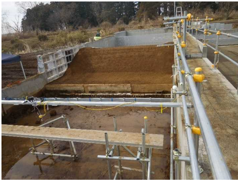
図 20 完成した越水試験堤防
