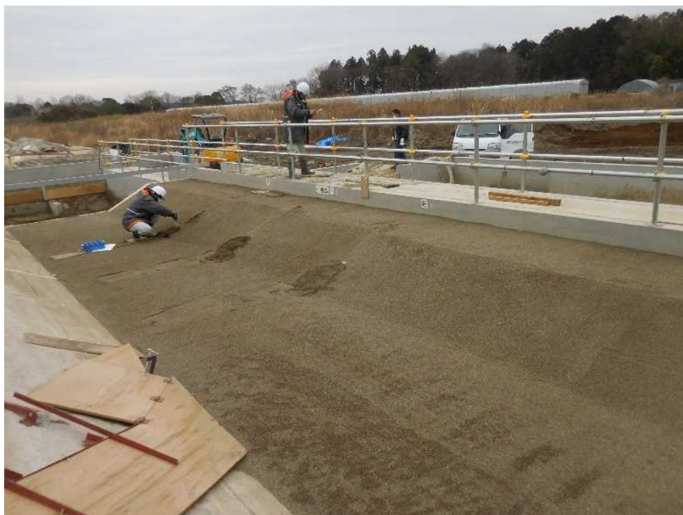
図 22 法尻センサ設置作業
