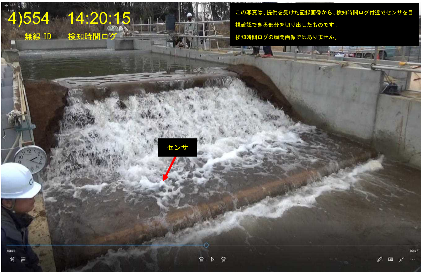
図 38 越水試験検知写真 (4)
