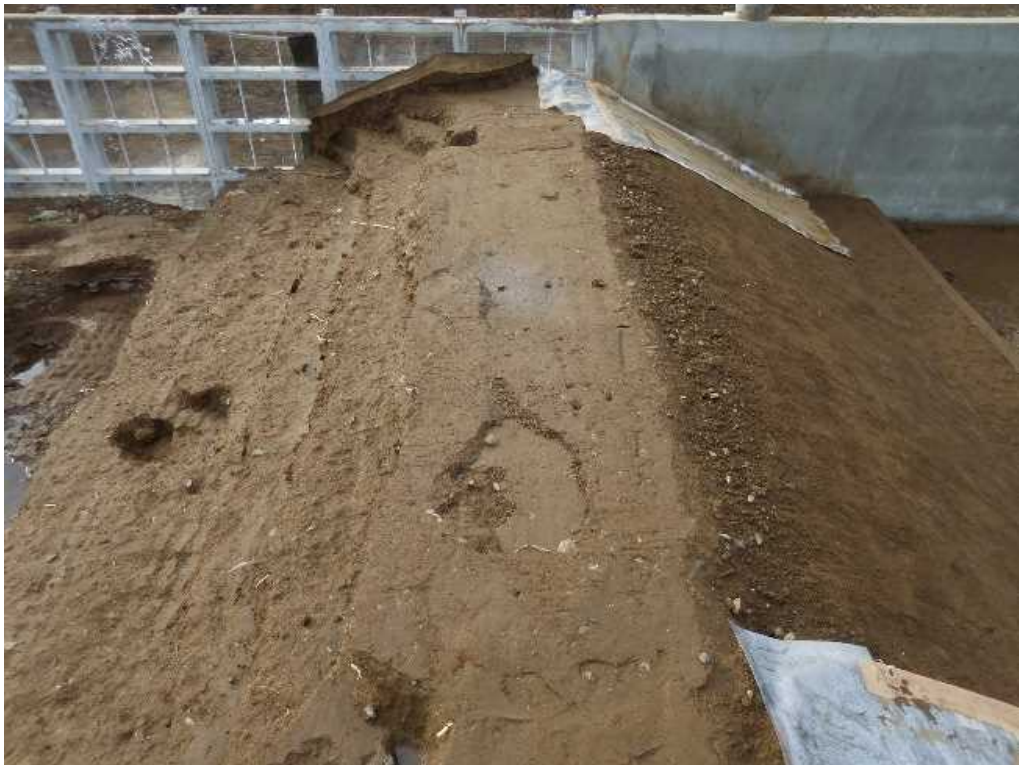
図 48 試験終了後の堤体状況
