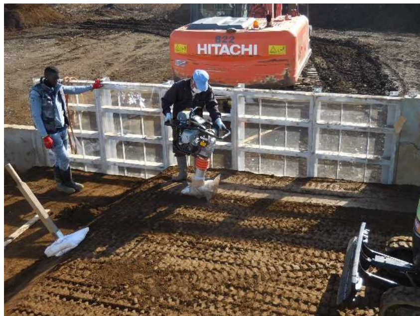
図18 締め固め作業(1)
