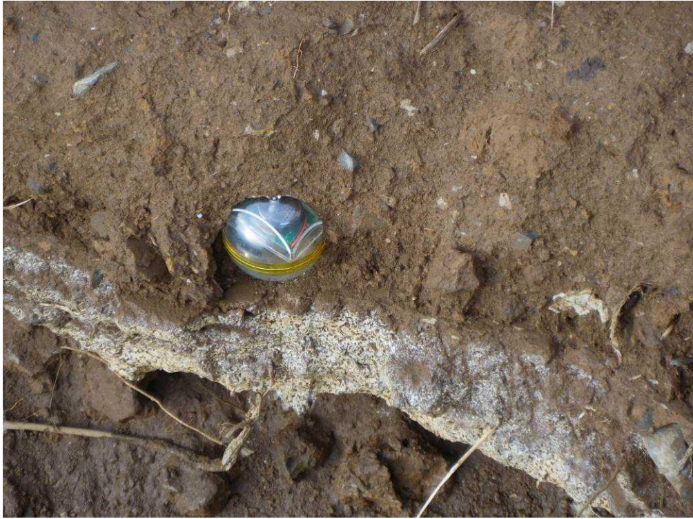
図 49 裏法尻センサ（未検知 上流に向かって右端）
