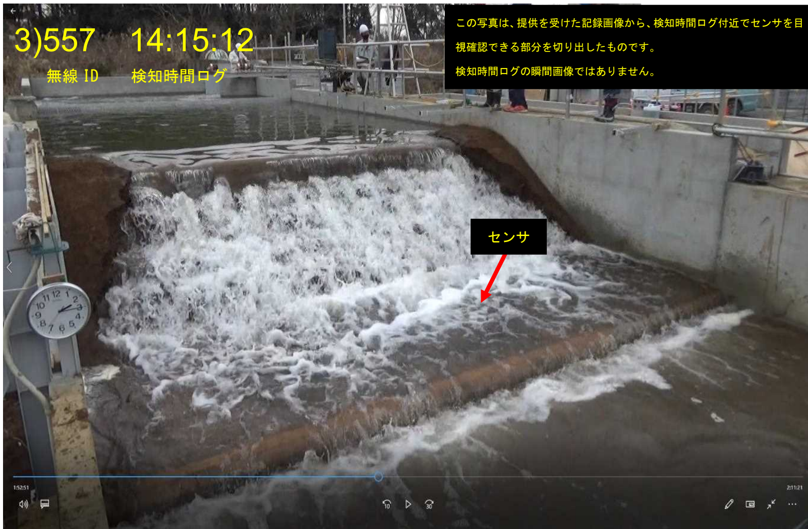
図 37 越水試験検知写真 (3)
