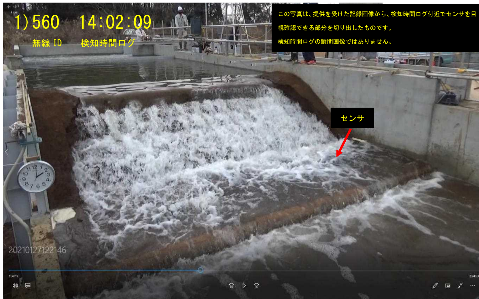
図 35 越水試験検知写真 (1)
