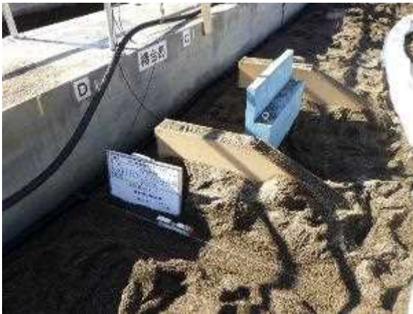
写真 5-2 振動補助金物配置（「橋台部」「護岸橋台部」）
