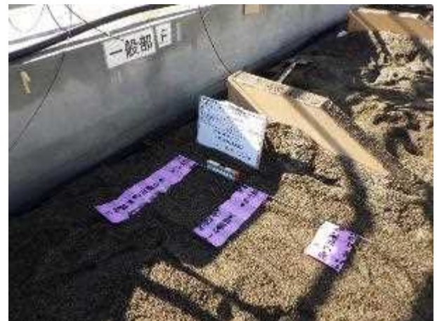
写真 5-3 埋設表示シート付振動補助金物（「一般部」）
