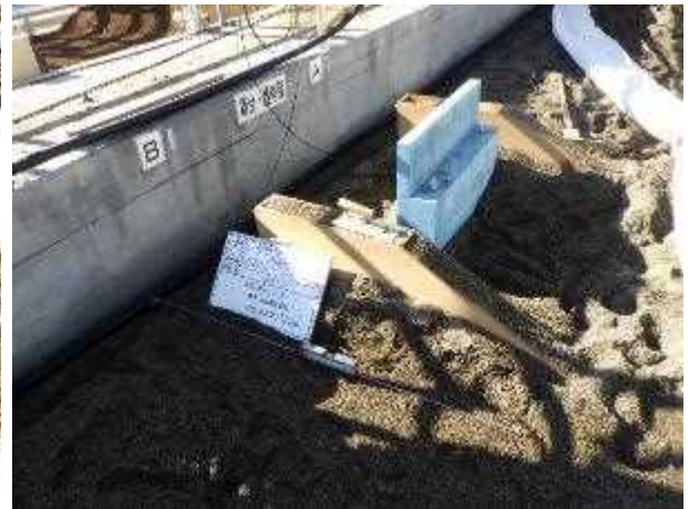
写真 5-2 振動補助金物配置（「橋台部」「護岸橋台部」）
