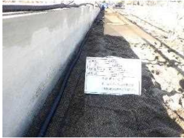
写真 5-1 配管状況（天端より 40cm 下がり）
