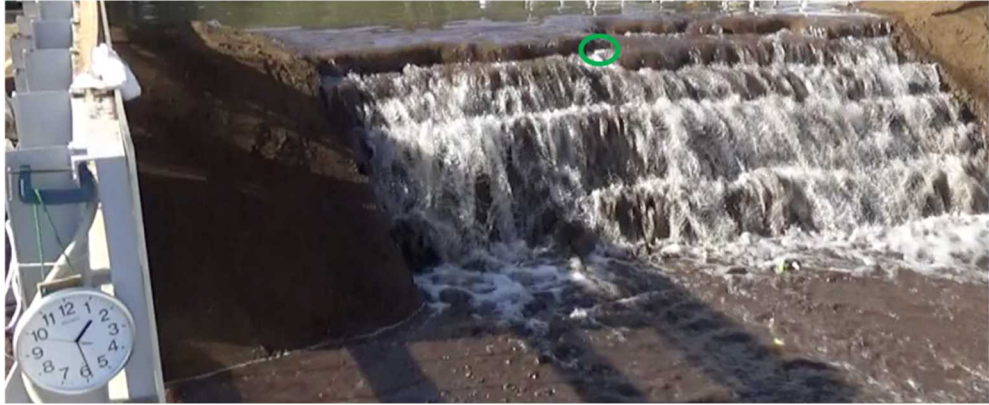
図 10 センサー側が剥き出しになっている様子 (13:28)
