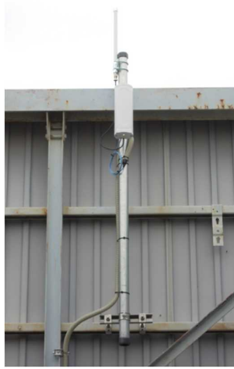
図 5 屋外型 LoRaWAN ゲートウェイの設置例 (当社事例)
