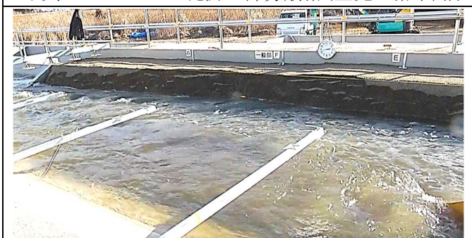
写真 17 14:42:40 堤防の部分崩落(土塊で落下)前
