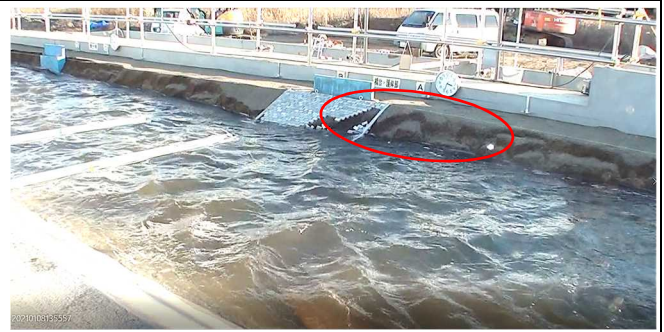
写真 38 15:33:40 堤防の継続的な部分崩落(土塊で落下)開始
