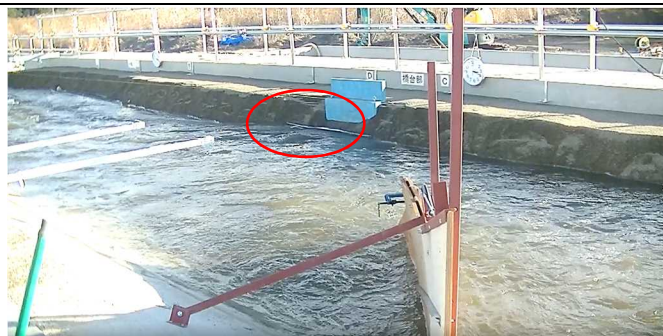
写真 29 15:19:00 堤防の継続的な部分崩落(土塊で落下)開始後
