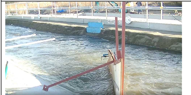
写真 28 15:18:00 堤防の継続的な部分崩落(土塊で落下)開始前
