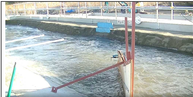
写真 26 15:17:20 堤防の部分崩落(土塊で落下)前
