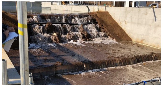
写真 8 13:13:34 堤内地側 FEP 管露呈(全て露呈)
