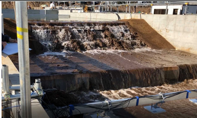
写真 7 13:12:08 堤内地側 FEP 管露呈(半分露呈)
