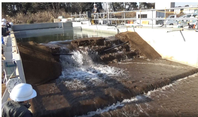
写真 9 13:36:24 堤外地側 FEP 管露呈(露呈開始) ※堤内地側 FEP 管は水流が当たる状態
