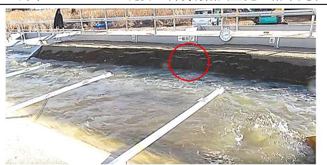
写真 18 14:42:50 堤防の部分崩落(土塊で落下)後
