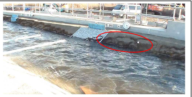
写真 36 15:26:35 堤防の部分崩落(土塊で落下)後
