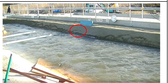
写真 25 14:48:00 堤防の上部 (水位より上部) の欠損開始後
