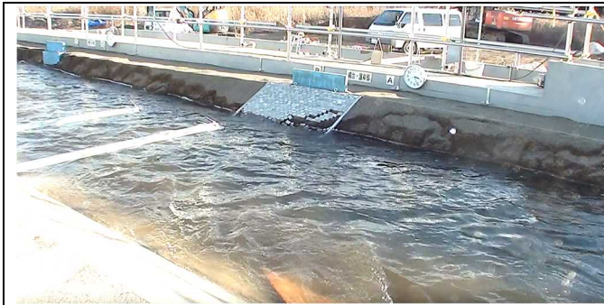
写真 35 15:26:10 堤防の部分崩落(土塊で落下)前
