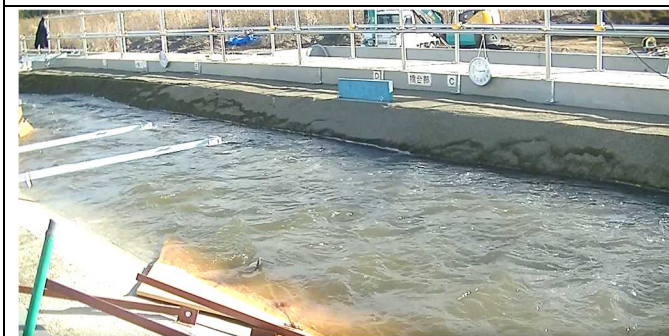
写真 24 14:47:00 堤防の上部 (水位より上部) の欠損開始前
