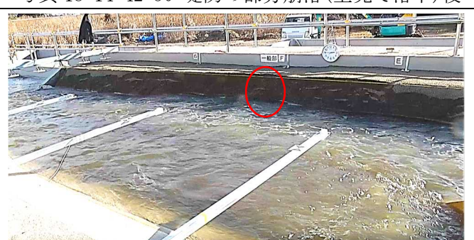
写真 20 14:46:10 堤防の部分崩落(土塊で落下)後
