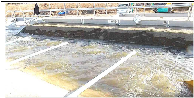
写真 15 14:38:27 堤防の部分崩落(土塊で落下)前
