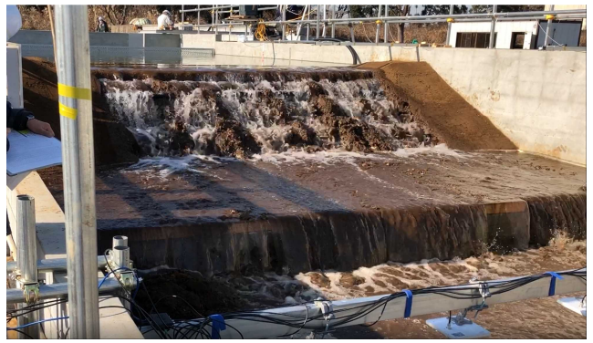
写真 6 13:09:07 堤内地側 FEP 管露呈(露呈開始)
