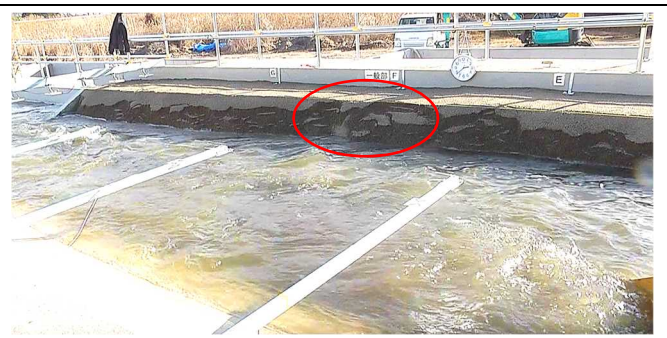
写真 16 14:38:35 堤防の部分崩落(土塊で落下)後
