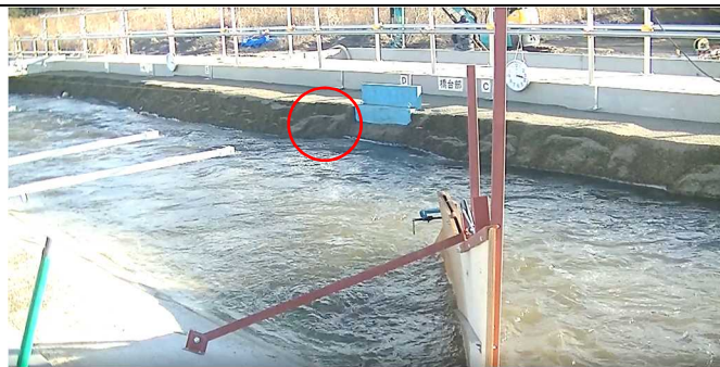
写真 27 15:17:30 堤防の部分崩落(土塊で落下)後
