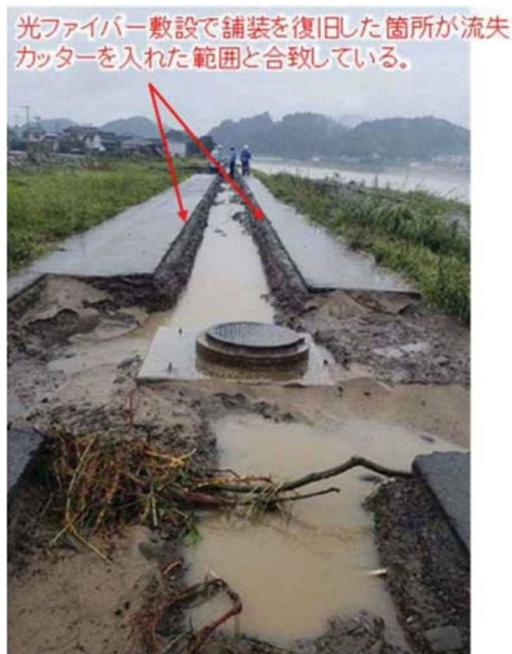
写真 2.3-6 被災箇所の舗装の流失の状況（その1）
