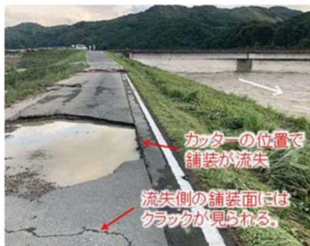
写真 2.3-7 被災箇所の舗装の流失の状況（その2）
