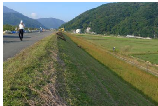
(参考) 除草直後の堤防法面のイメージ
