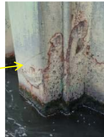
落差工付近(飛沫による腐食)
