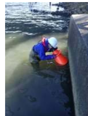
箱めがねによる 水中部目視調査
