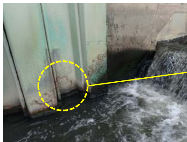
落差工付近(飛沫による腐食)
