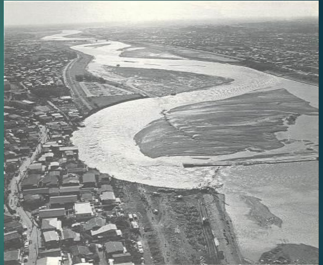
1974年多摩川左岸堤防迂回流により破堤
