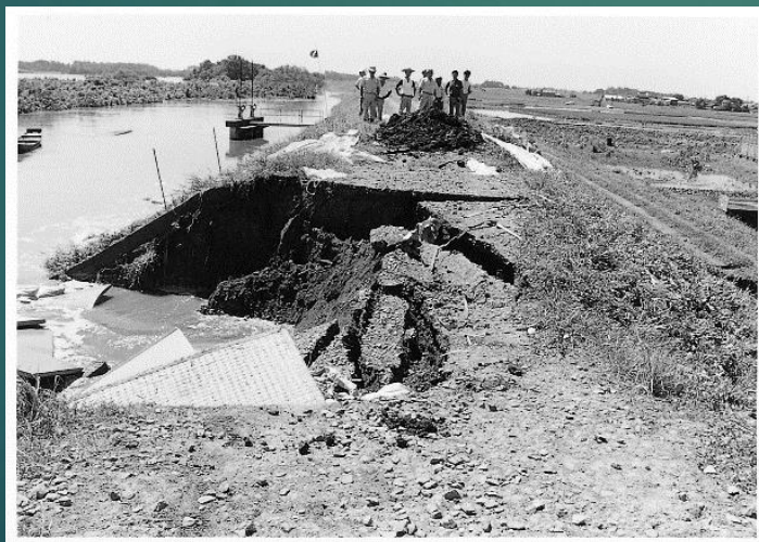
川面側が陥没
