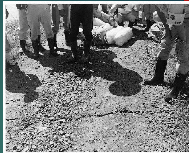
天端に横断方向の亀裂が発生
