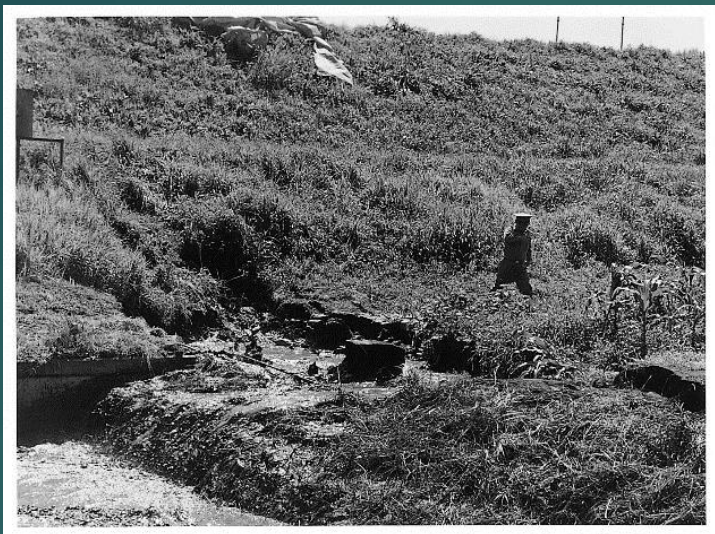
樋門の脇から漏水が発生
