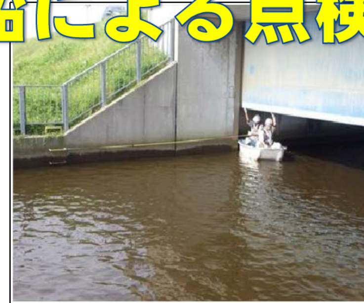
水深が深いところの点検
