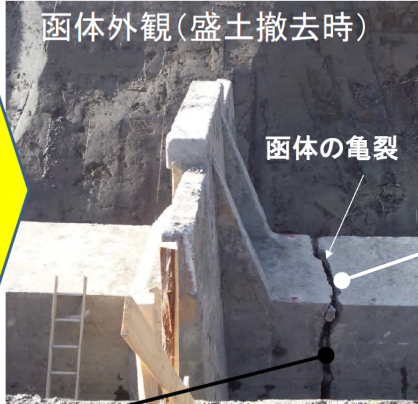
揚水樋管(許可工作物)の堤防天端に陥没が発生
