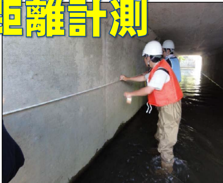
距離の計測 函体内に吐口を起点に5m間隔に距離標を記載する。
