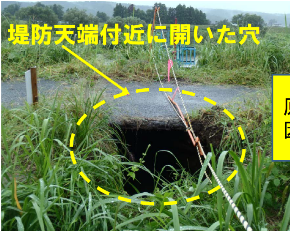
揚水樋管(許可工作物)の堤防天端に陥没が発生
