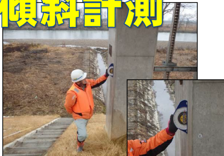
門柱の傾倒の計測
