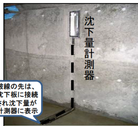
【点検に配慮した樋門樋管の設置イメージ】
