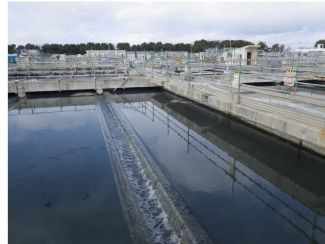
応急復旧の事例 (仮設沈殿池・既設)
