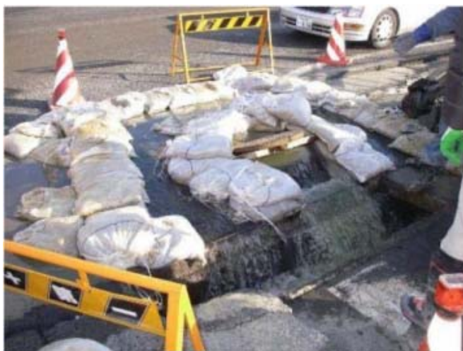
①土のう仮設水路
