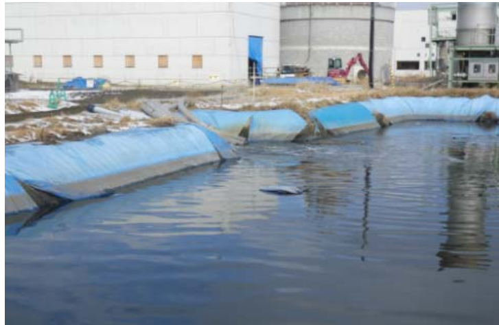
応急復旧の事例 (仮設沈殿池・素堀)
