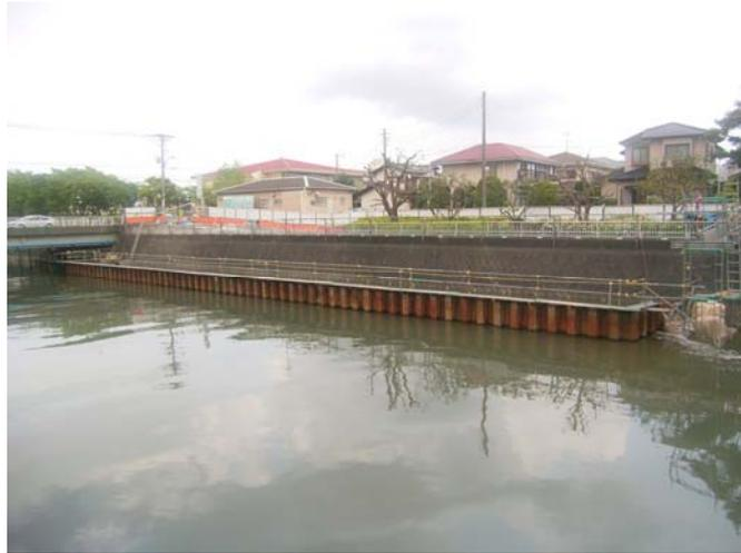
図 2.4 川の一部を締め切り簡易沈殿処理を行った事例（千葉県習志野市）
