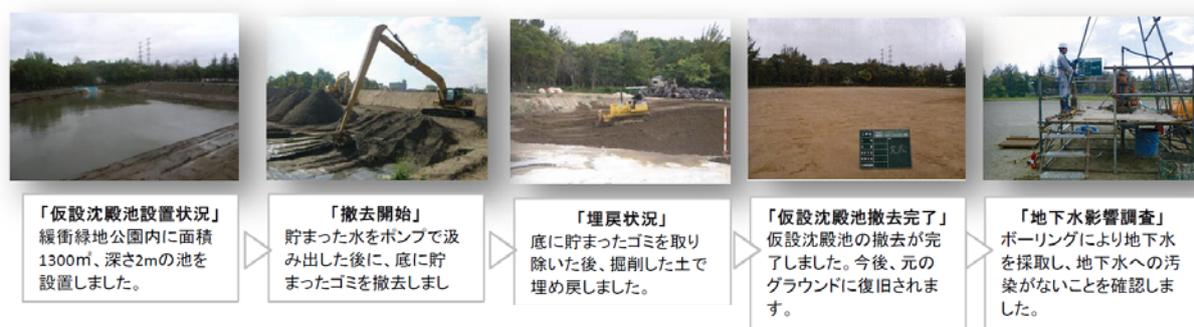
図 3.5 仮設沈殿池の設置事例（宮城県仙塩浄化センター）
