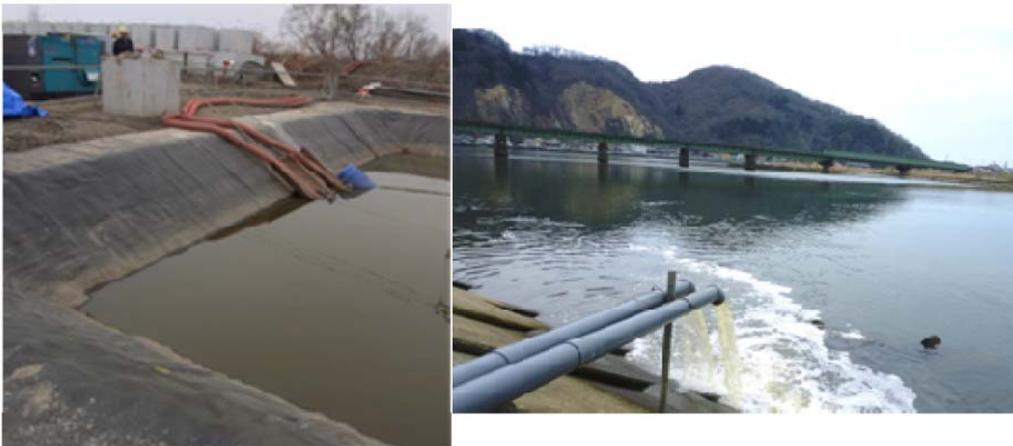
図 2.8 ポンプ場や幹線管渠人孔から河川等に簡易処理放流した事例
