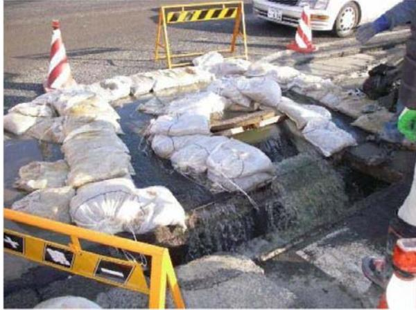
図 2.2 土のうを使用し近傍水路へ導水した事例（宮城県多賀城市）
