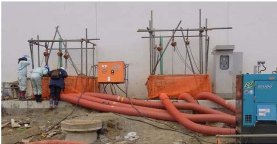
図 2.7 仮設ポンプの設置状況（宮城県石巻東部浄化センター）
