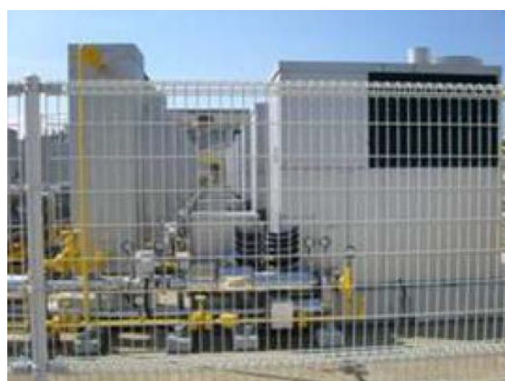
図 9 (左)シロキサン除去ユニット、(右)マイクロガスエンジン CGS
